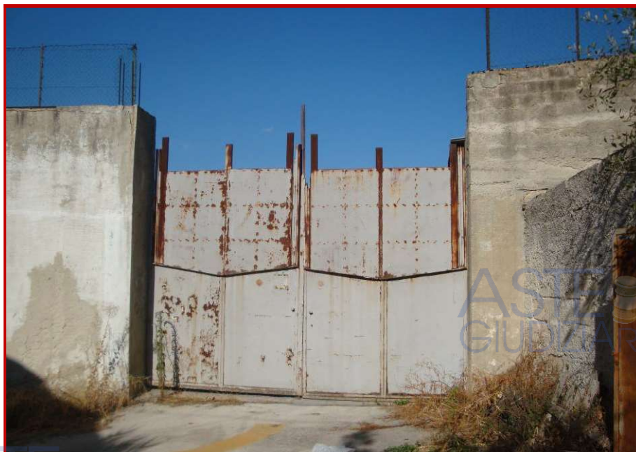
FOTO 3 - Prospetto sud ovest- apertura carrabile
