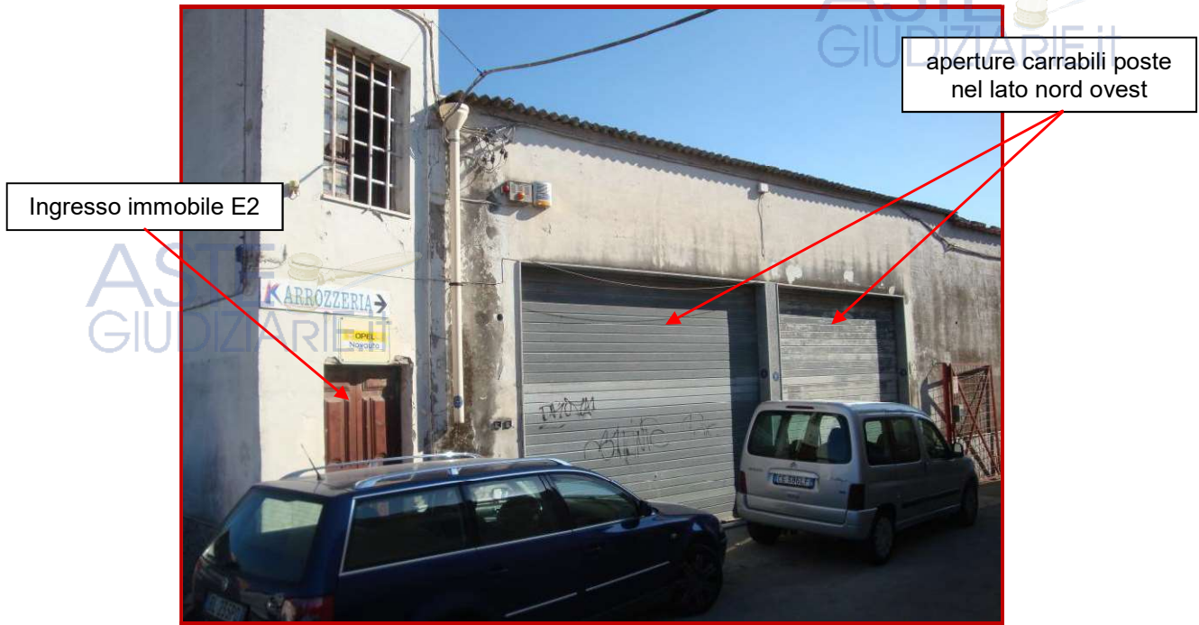
FOTO 2 - Prospetto nord ovest
