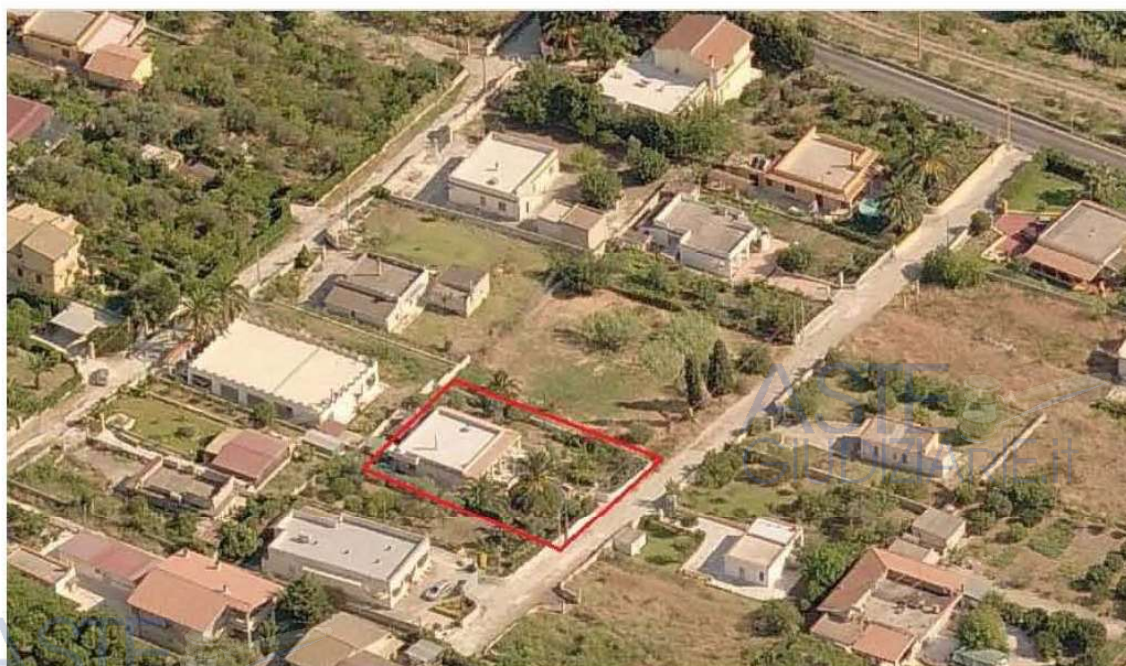
Fig.3: Particolare dell'immobile e del terreno di pertinenza oggetto di esecuzione, riquadrati in rosso
