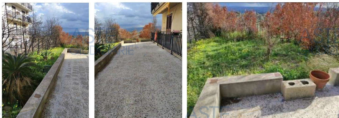
Foto 38,39,40,41,42,43. Balcone 2 e Terreno di pertinenza lato Est
