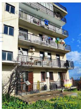
Foto 2,3,4. Fabbricato in cui è sito l'immobile
