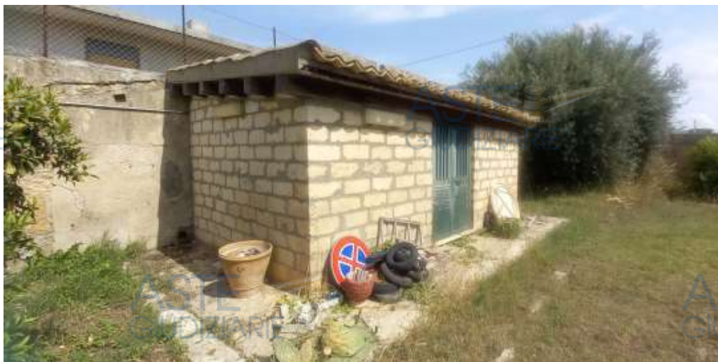
Foto 33 – Immobile "1A" – Locale deposito, non censito in Catasto
