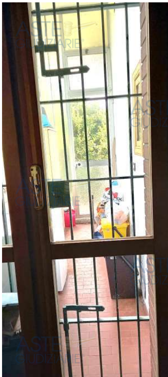
Foto 22 – Immobile “1A” – Lavanderia
