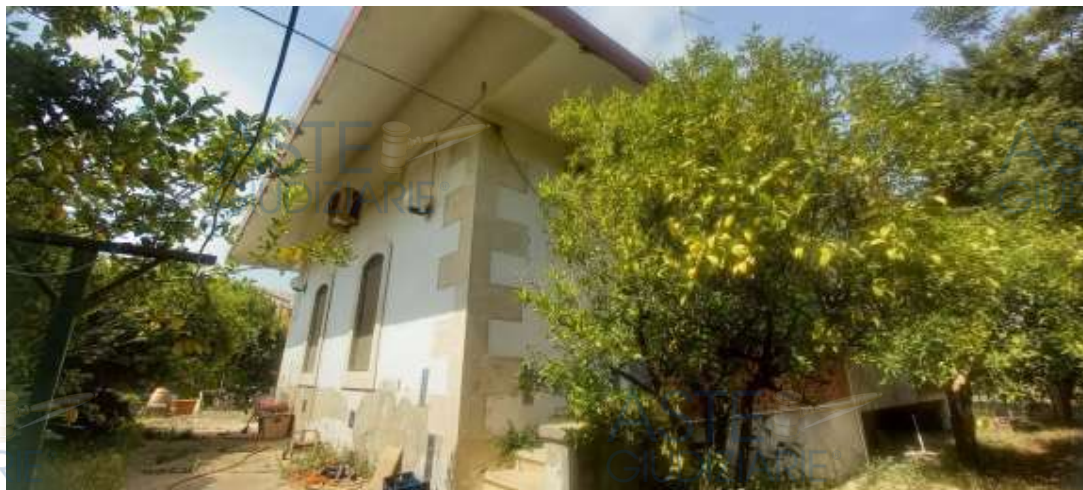
Foto 8 – Immobile “1A” – Prospetto Est
