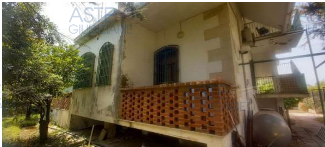
Foto 10 – Immobile “1A” – Prospetto Nord
