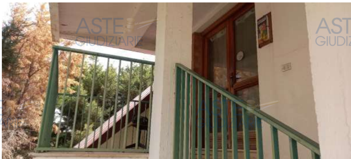
Foto 13 – Immobile “1A” – Locale sottotetto al I P
