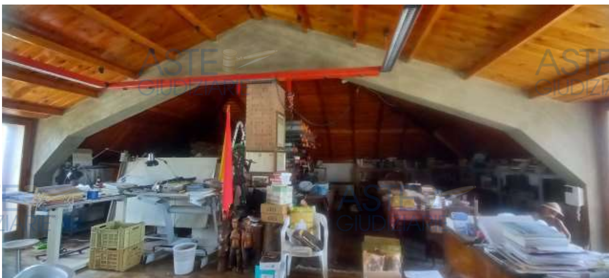
Foto 32 – Immobilità “1A” – Locale sottotetto al I P
