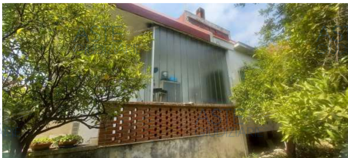
Foto 9 – Immobile “1A” – Prospetto Nord (veranda adibita a lavanderia)
