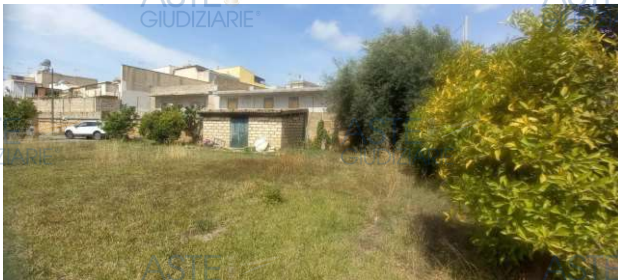
Foto 14 – Immobile “1A” – Locale “deposito”
