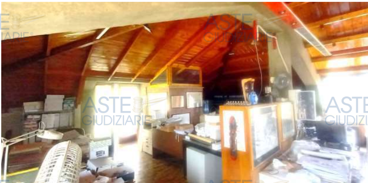
Foto 31 – Immobilità “1A” – Locale sottotetto al I P
