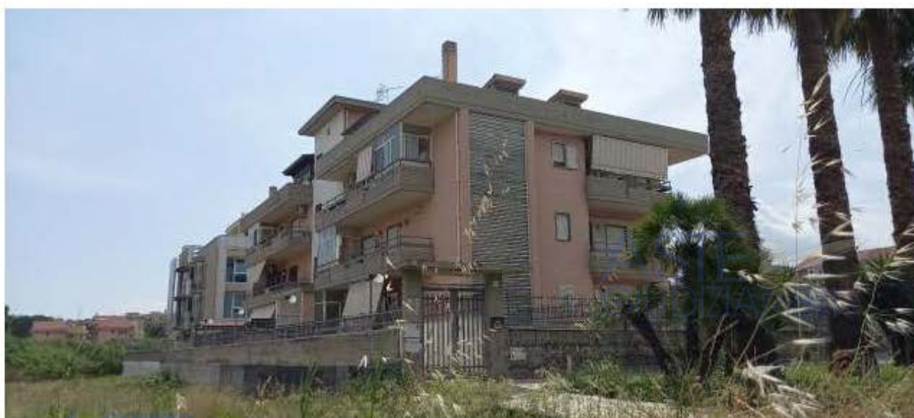
Foto 2 – Immobile "1A" – Veduta prospettica su viale R. da Lentini
