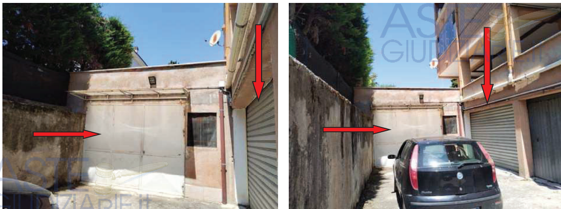
Vista esterna dei due garage di cui alla proprietà "B", in viale Umbria
