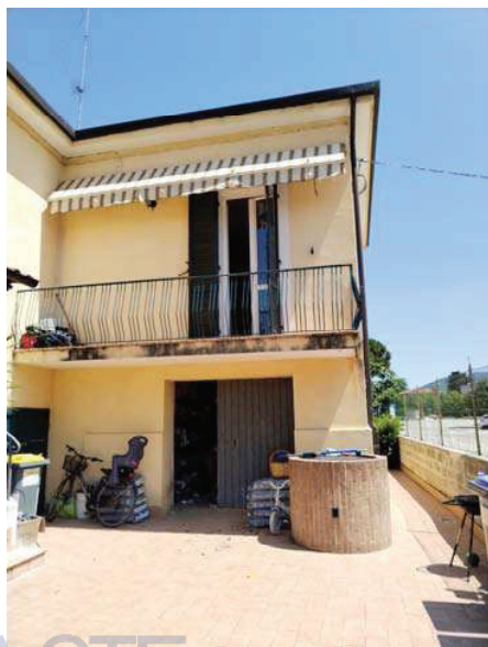
Balcone sul prospetto sud-ovest
