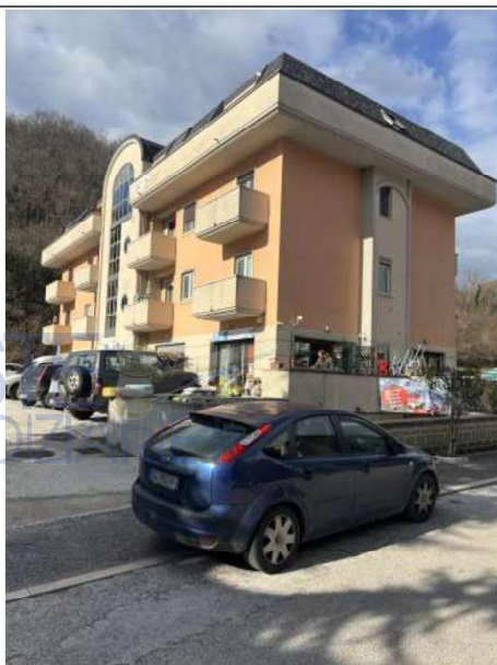
(foto 1: prospetto principale)
