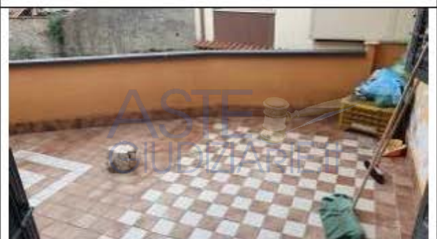
Foto terrazzo abusivo
