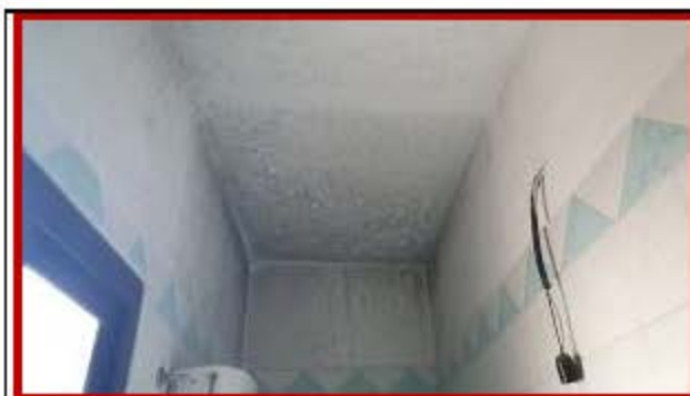
Vista soffitto w.c. 2
