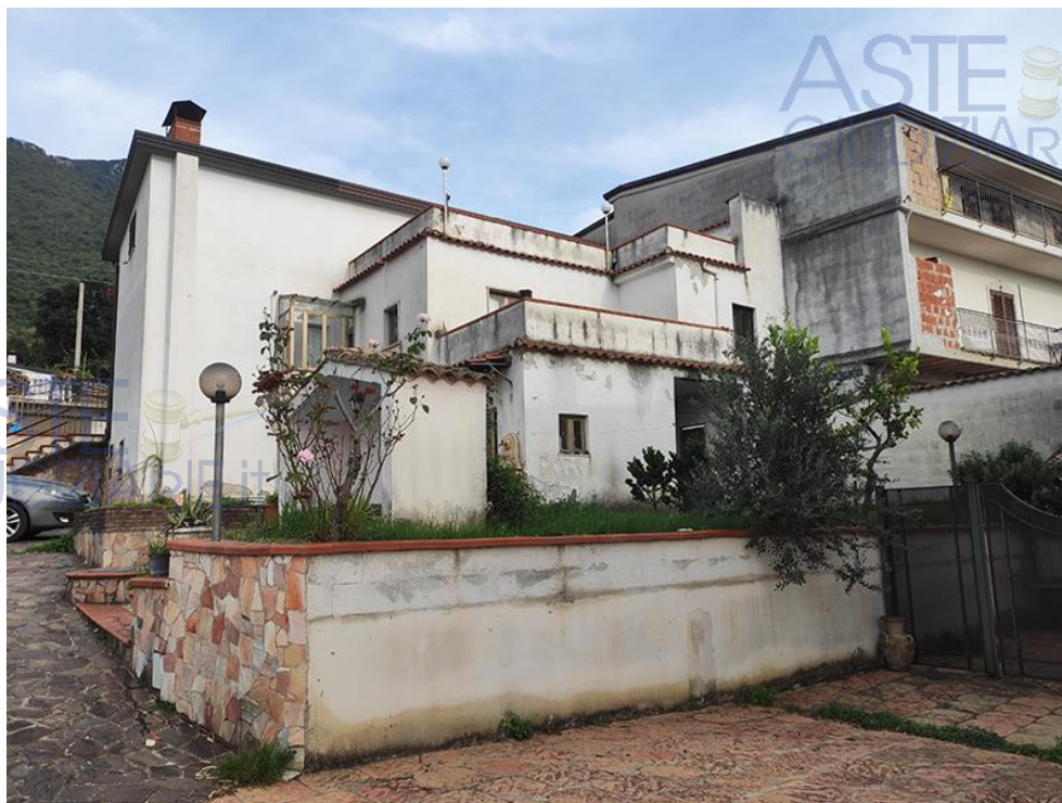
Vista dell'immobile da ovest (cortile interno)
