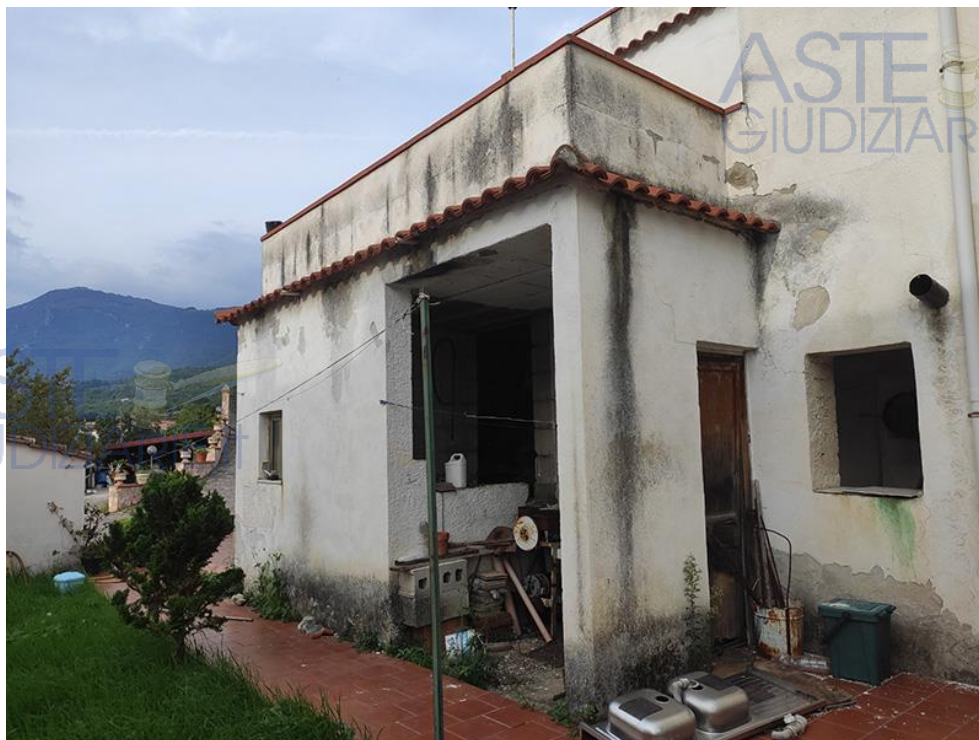
Vista dell'immobile da sud/ovest (cortile interno)
