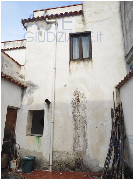
Vista dell'immobile da ovest (cortile interno)
