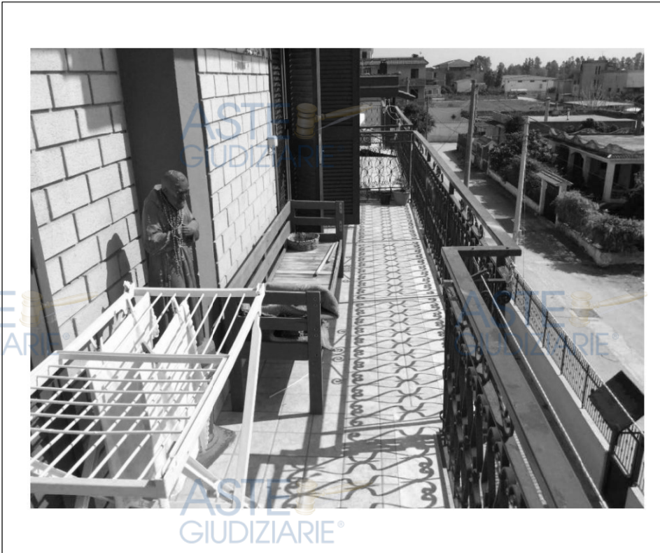
Balcone lato sud
