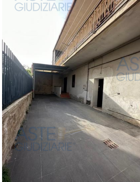
Foto n.3 – particolare corte d'accesso
