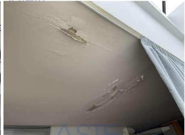
Foto 53-54: macchie d'infiltrazioni acque meteoriche
