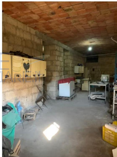
Foto n. 3 – Particolare locale deposito
