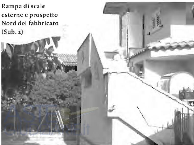
La copertura è stata realizzata con struttura lignea a falde inclinate e manto di copertura formato da tegole in argilla del tipo portoghesi.
