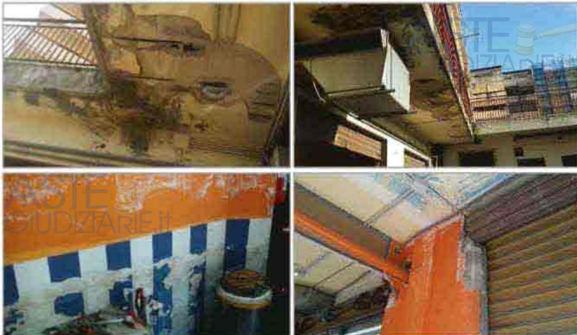
**Ammalarimenti per copiosi e risalenti fenomeni infiltrativi** si riscontrano all'interno dell'area destinata ad autorimessa, sia all'esterno, in corrispondenza dello sporto della copertura, ove risalta il distacco anche del copri ferro delle armature.
