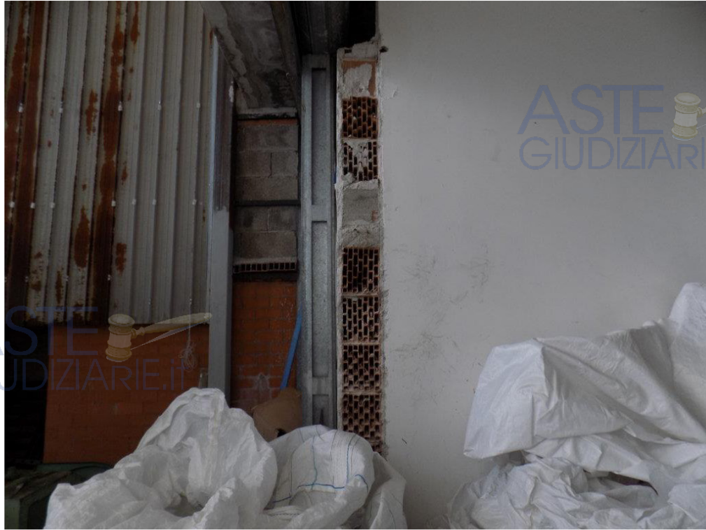
Foto 11 e 12: Dettagli della tompagnatura in laterizi forati rimossa per realizzare l'ampliamento attraverso la struttura metallica di alloggiamento dell'estrusore precedentemente illustrato.
