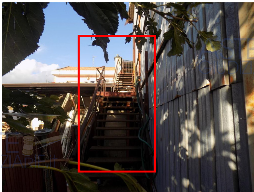
Foto 17: Scala metallica ubicata in corrispondenza del prospetto retrostante. Suddetta scala è di semplice passaggio sulla corte ed adduce all'unità immobiliare posta al piano superiore che non fa parte del lotto uno.
