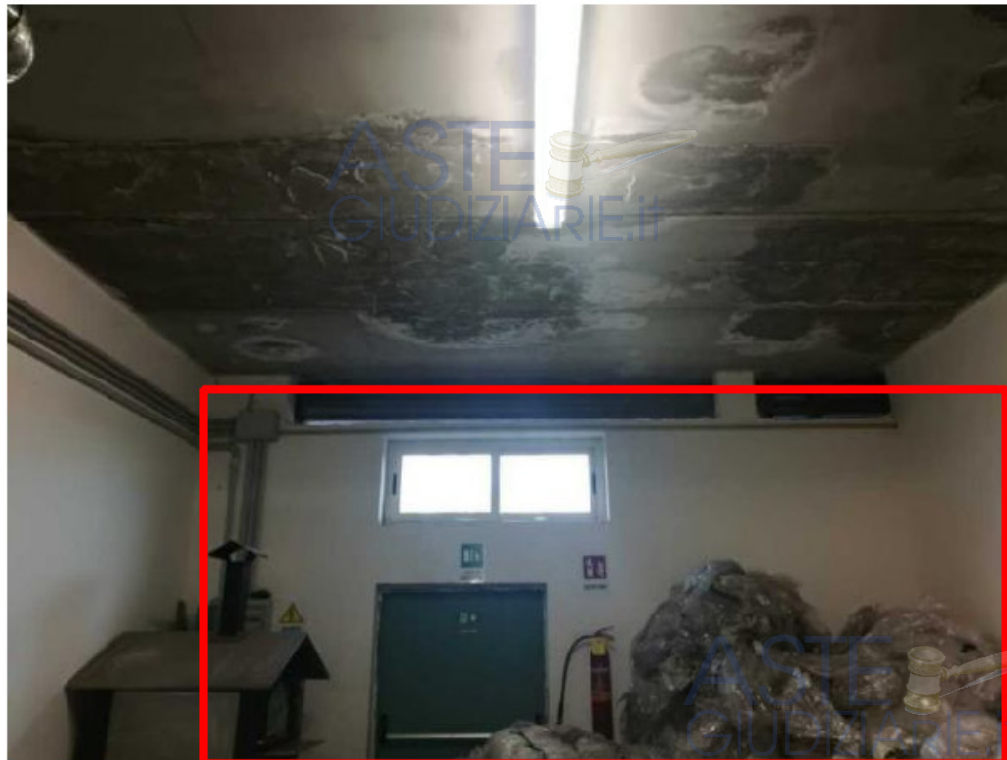
Foto 4: Parete lato sud, oggetto di demolizione, per consentire l'intercomunicazione con la struttura metallica in ampliamento accertata sui luoghi.
