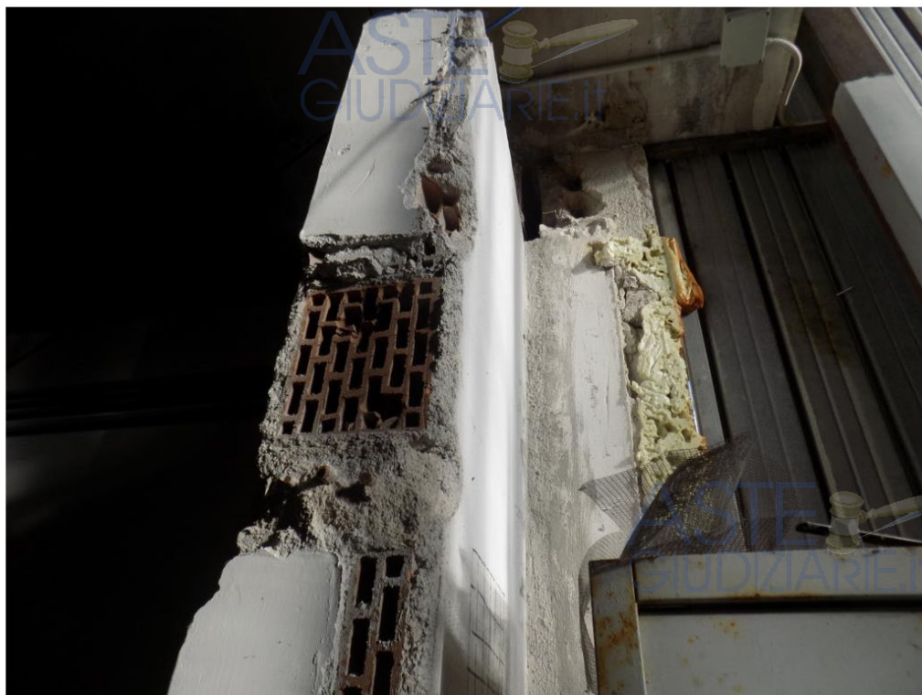
Foto 11 e 12: Dettagli della tompagnatura in laterizi forati rimossa per realizzare l'ampliamento attraverso la struttura metallica di alloggiamento dell'estrusore precedentemente illustrato.
