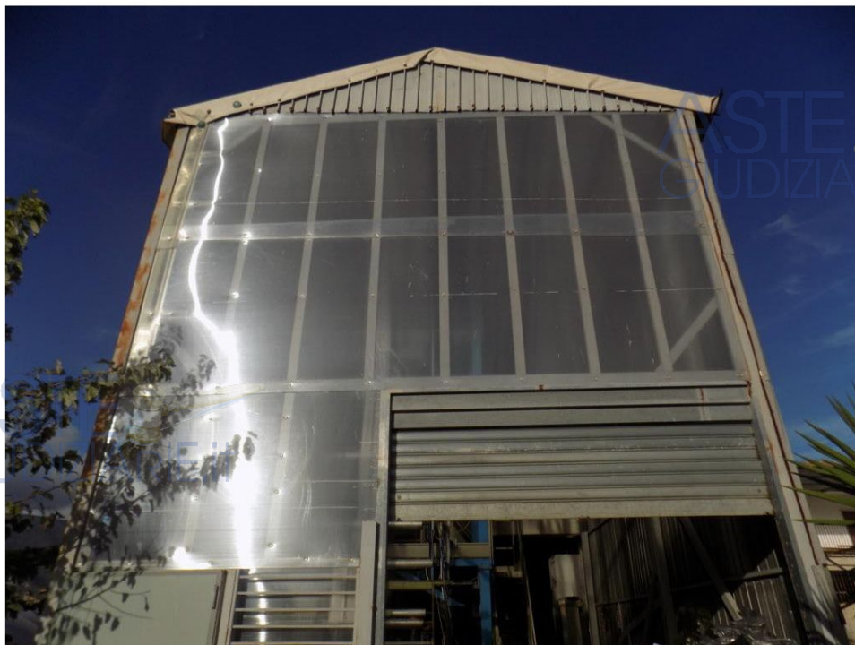
Foto 5: Prospetto lato sud della struttura aggiuntiva realizzata con intelaiatura metallica e pannelli trasparenti in materiale plastico. È visibile altresì la saracinesca di ingresso carrabile e l'aggancio dei teli di copertura a doppia falda.
