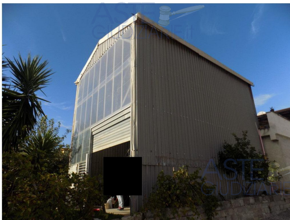
Foto 6: Prospetto laterale in lamiera grecata.
