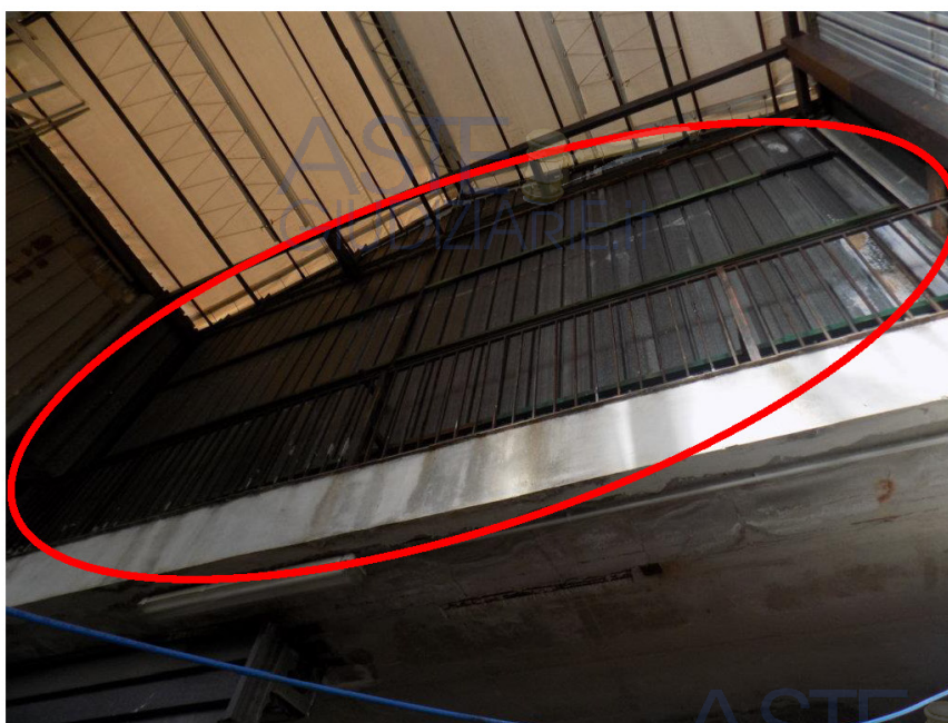
Foto 18: Il ballatoio di affaccio, posto al piano superiore rispetto al lotto uno, costituisce pertinenza di un bene estraneo alla presente procedura esecutiva. Tale ballatoio, in assenza di manufatto in acciaio, affacciava sulla corte retrostante sub.9.
