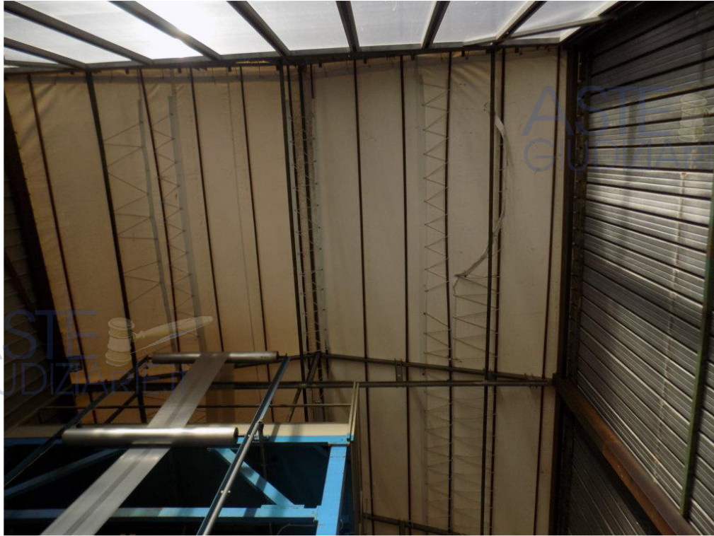
Foto 9: Particolari della copertura
