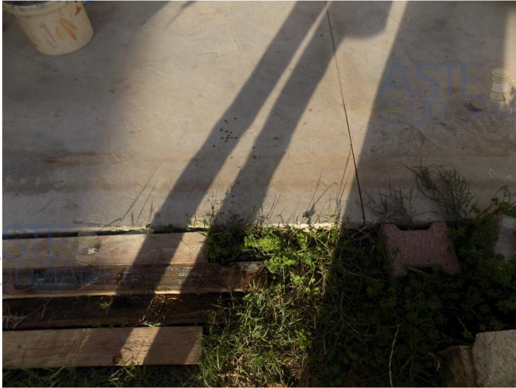
Foto 15 e 16: Dettagli del massetto cementizio di calpestio sul quale risultano imbullonati i ritti in acciaio della struttura metallica di ampliamento.
