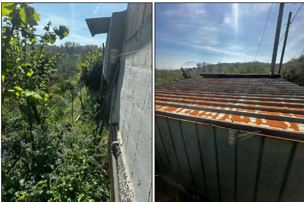
Foto 33-34: ulteriori viste degli esterni degli annessi/manufatti non censiti né accatastati ed insistenti su Part.lla 399 , con accesso tramite cancello al civ. 4 di Via Costa Maura. La copertura è in lamiera con struttura portante in legno.
