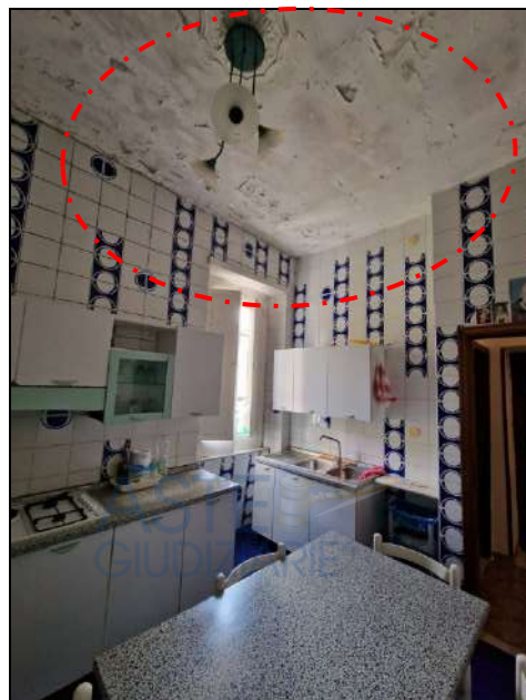
Foto 15-16: viste degli interni del LOTTO UNO (Appartamento al Piano Terzo Sub. 12), in particolare della cucina . Si notino tracce di infiltrazioni presenti nel vano che coinvolgono l'intero soffitto , con conseguente degrado dell'intonaco e sfogliature.
