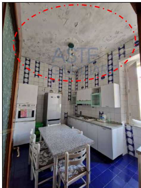
Foto 15-16: viste degli interni del LOTTO UNO (Appartamento al Piano Terzo Sub. 12), in particolare della cucina . Si notino tracce di infiltrazioni presenti nel vano che coinvolgono l'intero soffitto , con conseguente degrado dell'intonaco e sfogliature.
