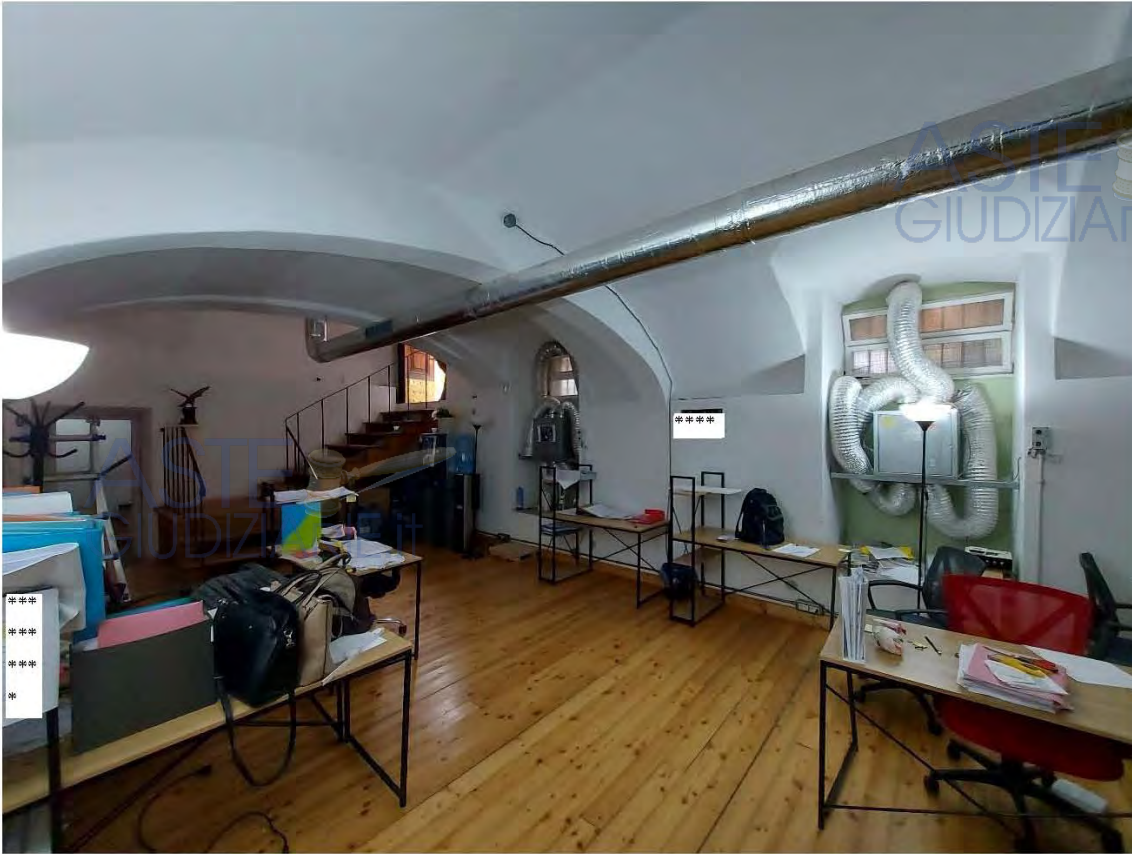
Locale sub. 540 al piano S1 verso la scala realizzata con il taglio del solaio
