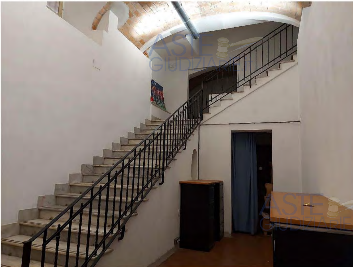
Dall'ambiente "B" verso scala di accesso dal civico 27
