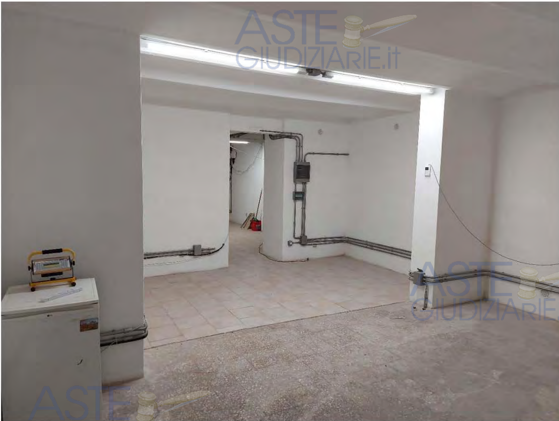
Locale "F" verso locale "G"
