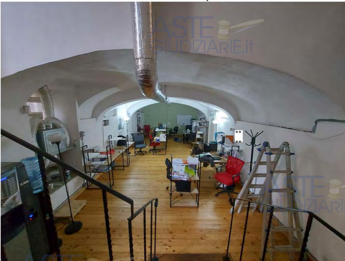
Locale sub. 540 al piano S1 dalla scala realizzata con il taglio del solaio
