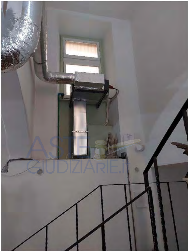
Finestra che in precedenza areava il servizio
