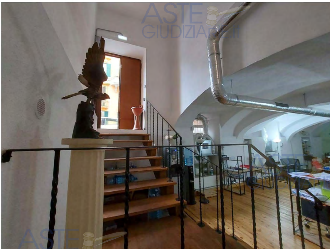
Scala realizzata con demolizione solaio del calpestio piano terra per accesso al piano S1 dal civico 25
