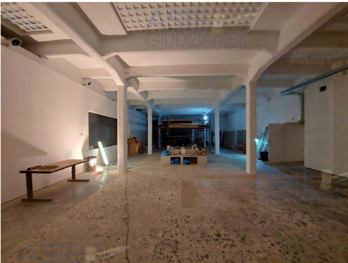
Locale "M" sottostante alla corte condominiale
