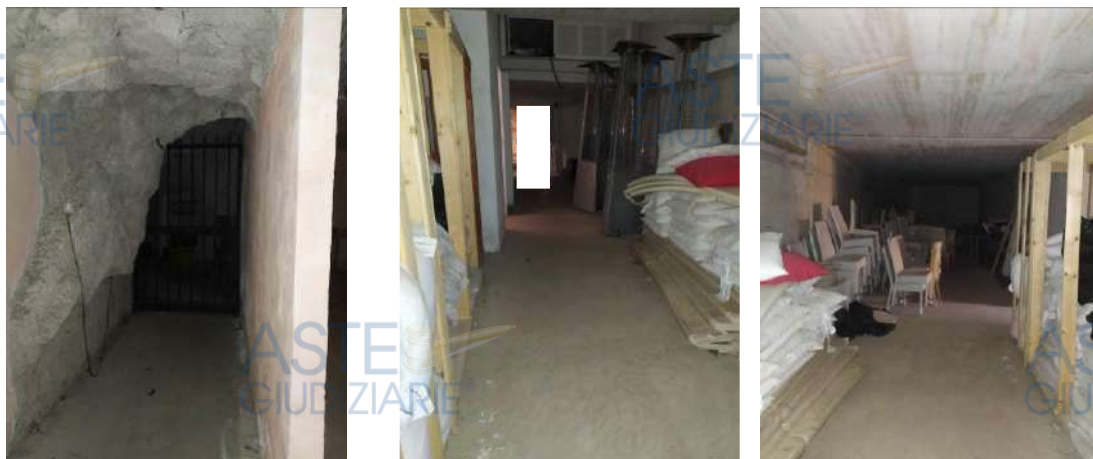
locali di pertinenza collocati al piano seminterrato
