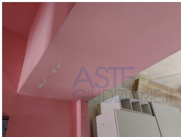
La tinteggiatura in fase di distacco nella parete della cucina e trave tra cucina e l'ingresso
