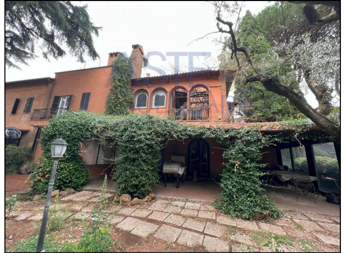
Vista esterna dell'immobile
