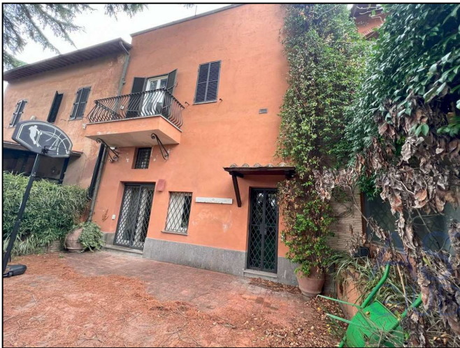
Vista esterna dell'immobile
