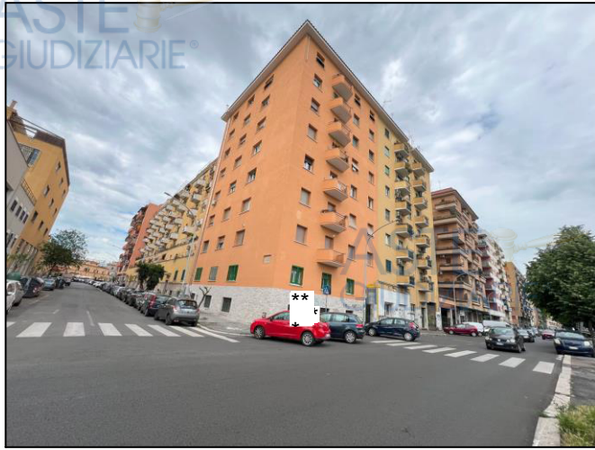
Vista del fabbricato tra Via di Portonaccio e Via Giuseppe Arimondi
