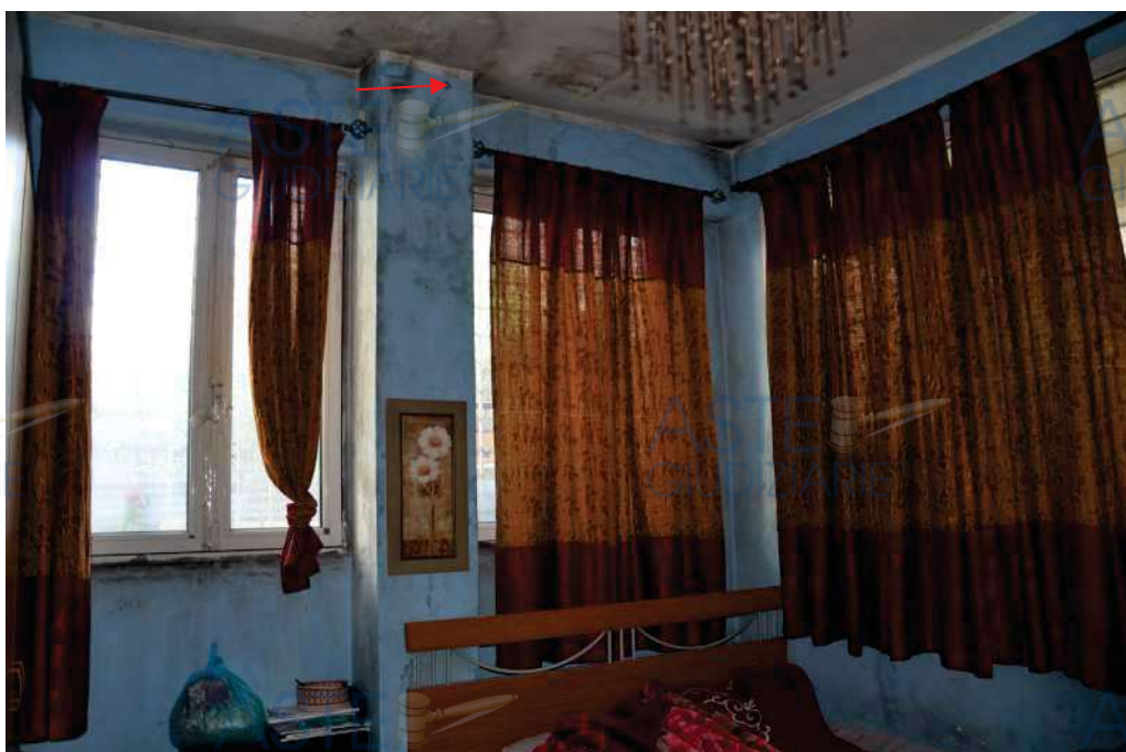
Muro nella camera (volume aggiunto)
