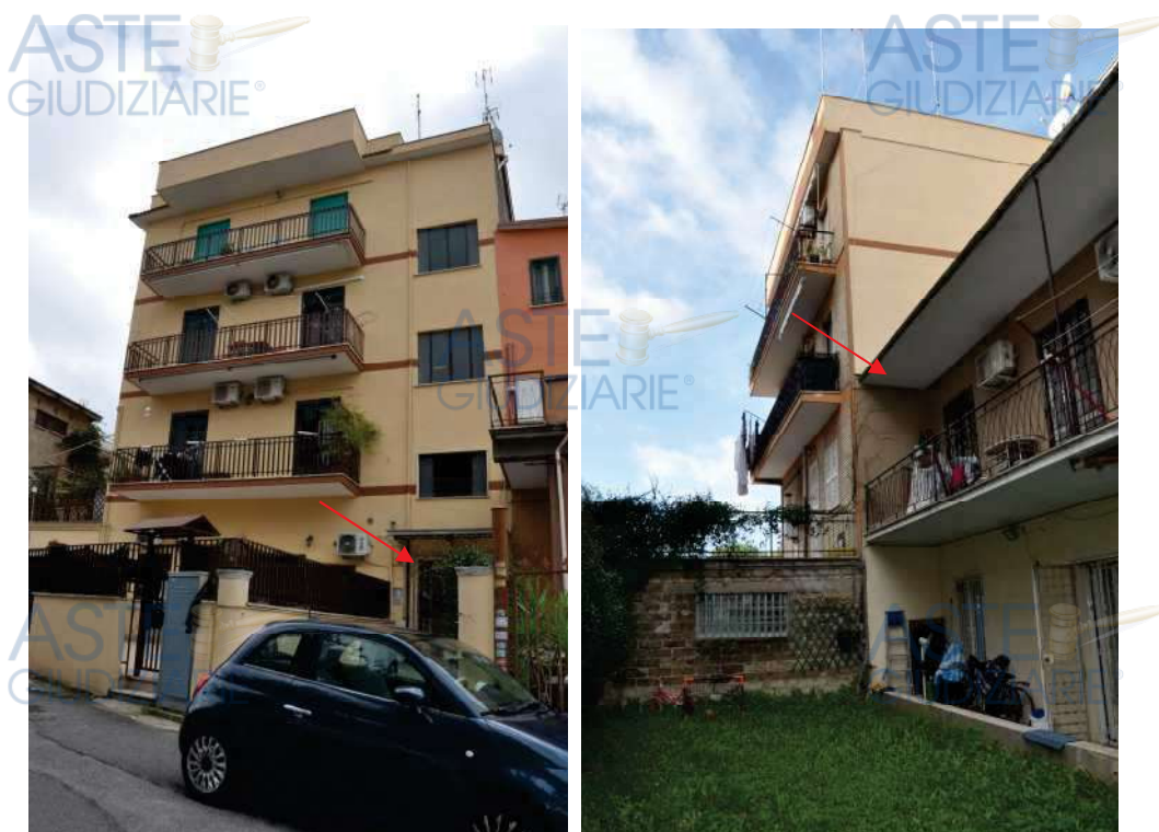
Ingresso all'edificio - fabbricato in esame
