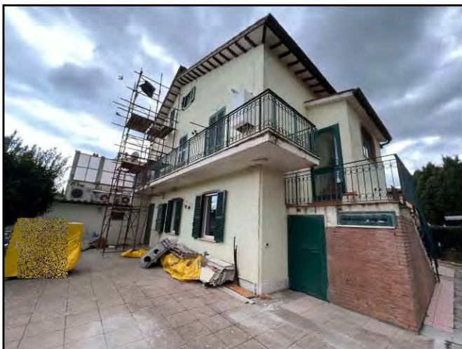
Vista retrostante dell'edificio dalla corte comune
