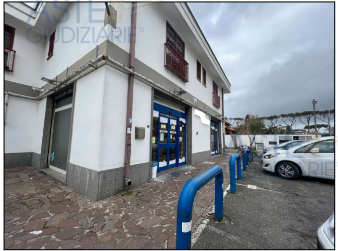
Vista dell'accesso su Via Salorno n. 18
