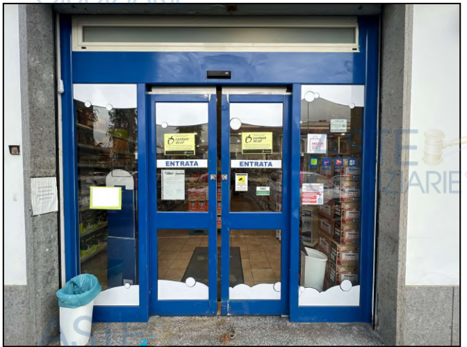
Vista dell'accesso su Via Salorno n. 18
