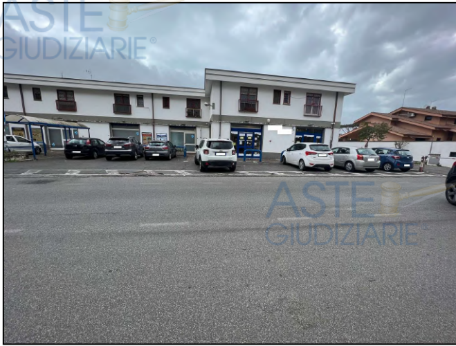
Vista esterna dell'immobile su Via Salorno
