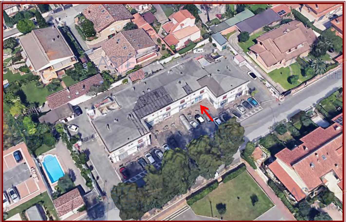
Vista 3D da Google Earth – Vista dell'accesso al locale commerciale posto su Via Salorno n. 20
