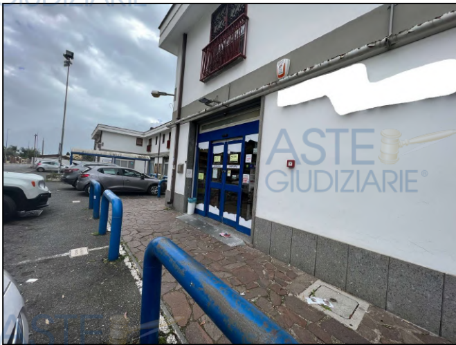
Vista dell'accesso su Via Salorno n. 18
