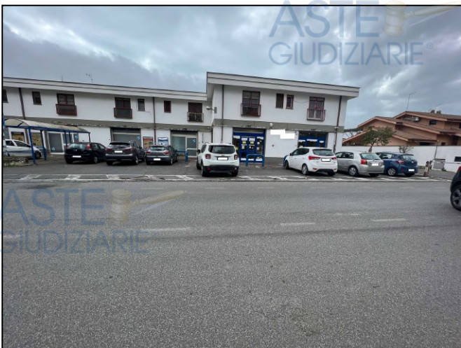
Vista esterna dell'immobile su Via Salorno
