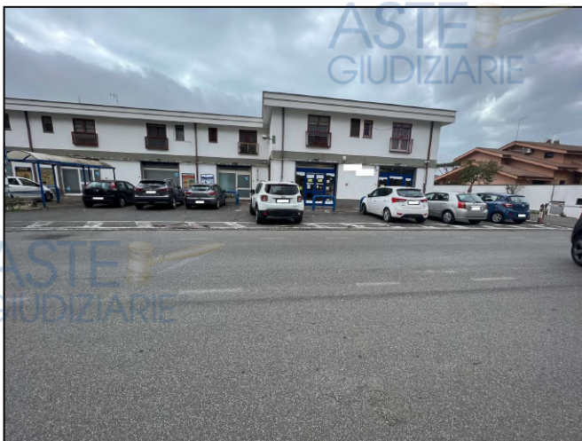
Vista esterna dell'immobile su Via Salorno
