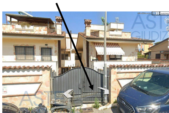
Ingresso rampa comune locale garage civ 58
