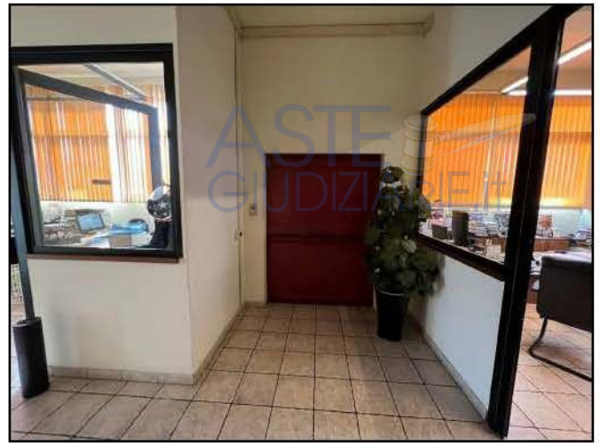
Montacarichi di collegamento tra i piani S1-T-1 censito come B.C.N.C. Fg 294, part. 530, sub. 594
