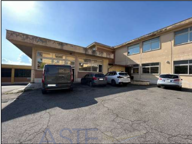
Vista esterna del fabbricato industriale
