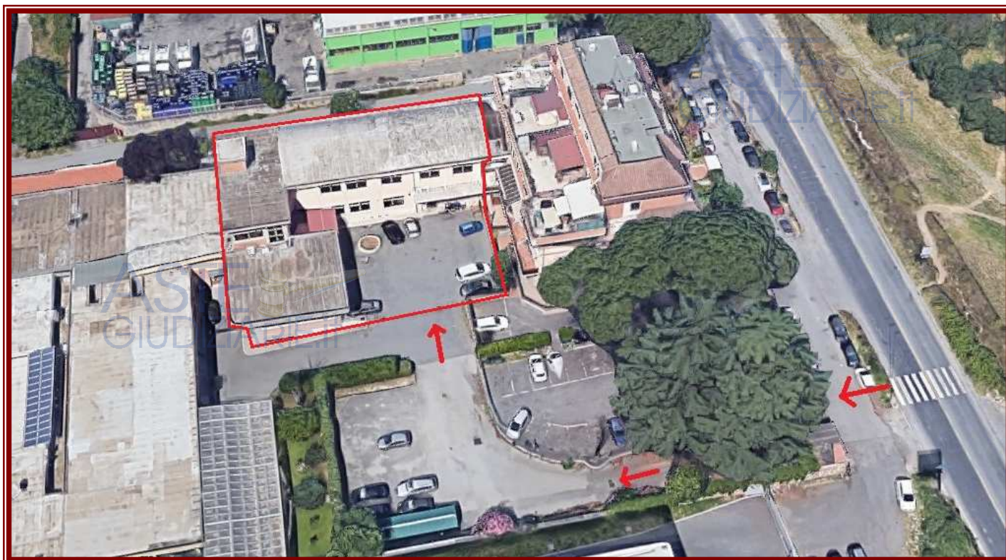
Vista 3D da Google Maps – lato “Est” – Inquadramento del fabbricato con accesso da Via Tiburtina 1470
