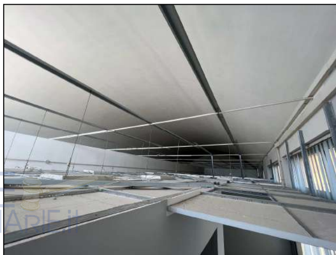
Vista della copertura con volta a botte
