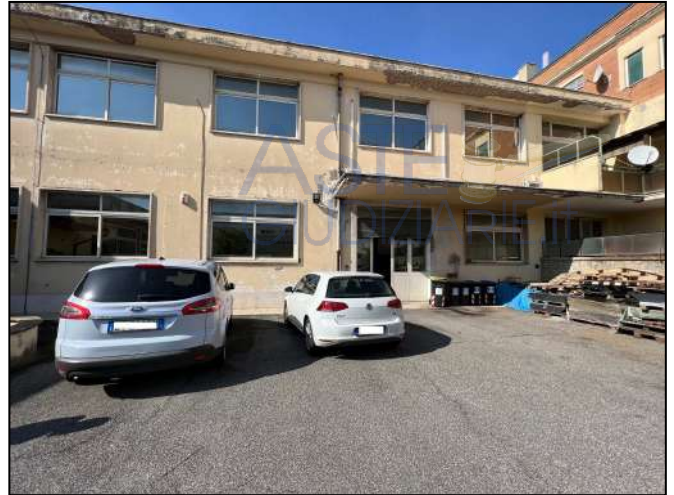
Vista esterna del fabbricato industriale
