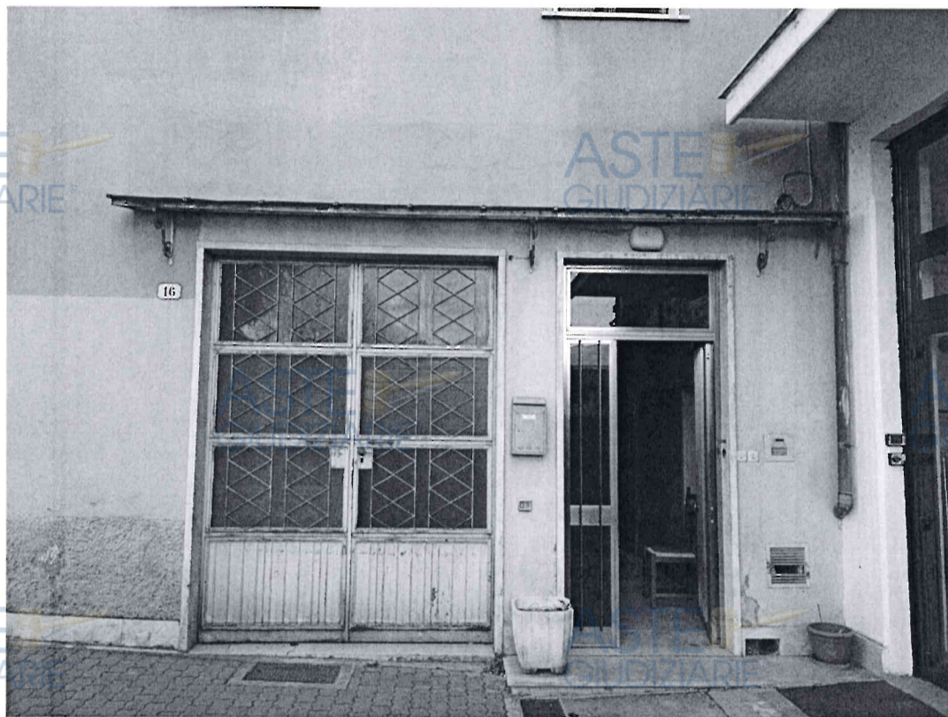
foto n°14 - ingresso abitazione a dx; vano garage a sx
