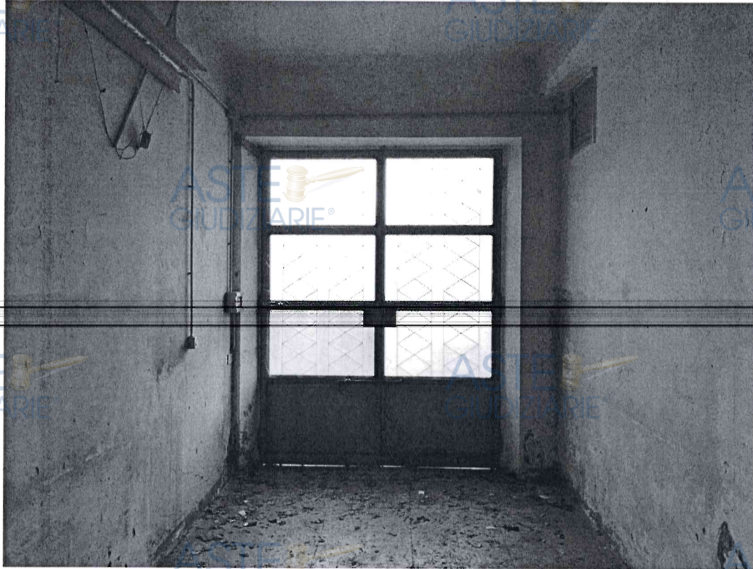
foto n°18 - garage piano terra
