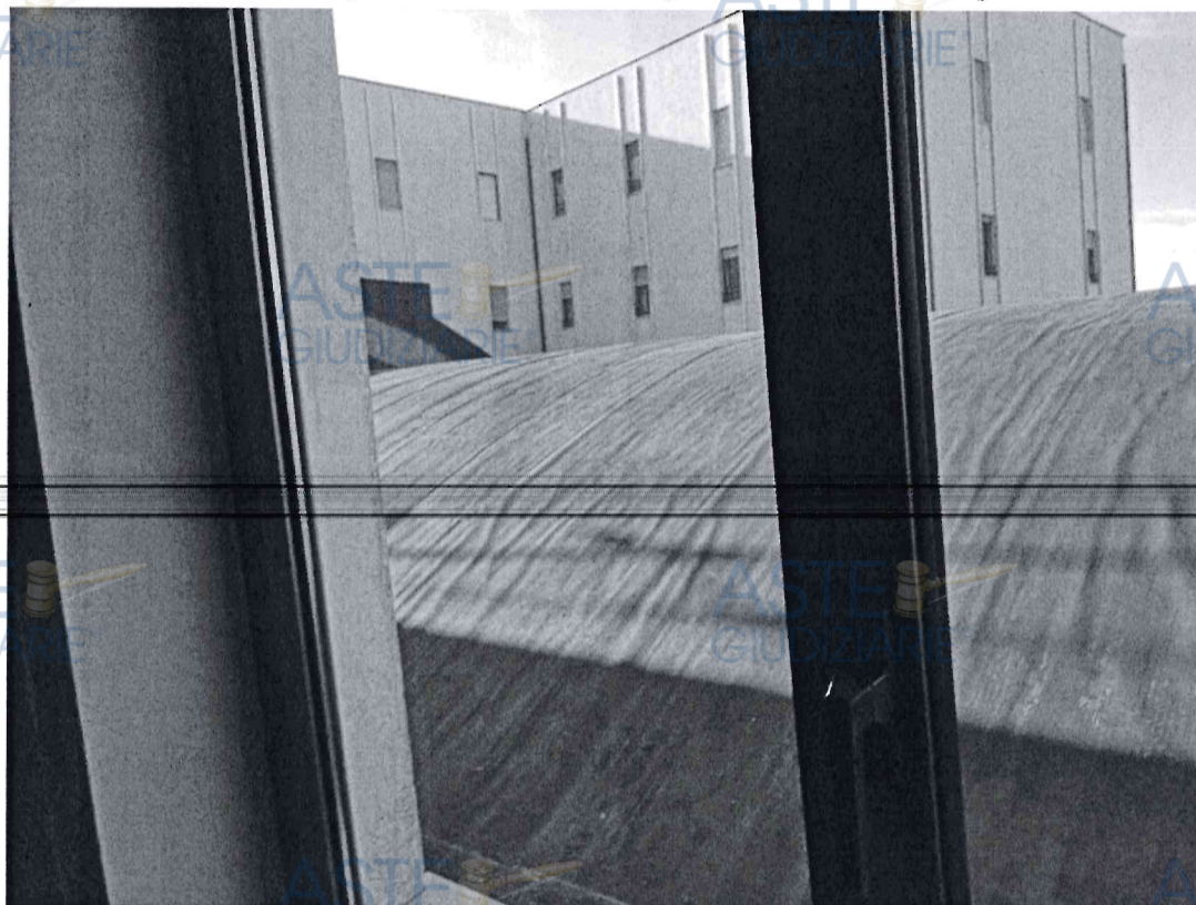
foto n°3 - copertura del locale commerciale vista da appartamento
