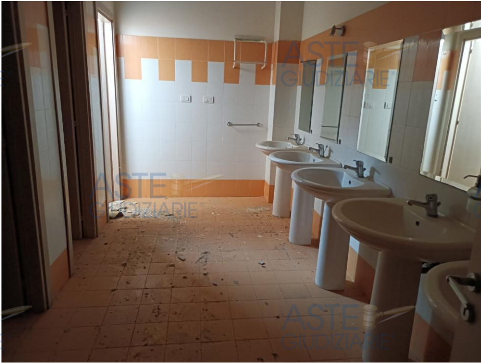
Foto n. 49 – Corpo E – Capannone – Mensa e servizi.
