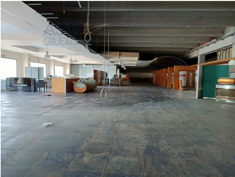
Foto n. 34 – Corpo B – Capannone – Sala esposizione.
