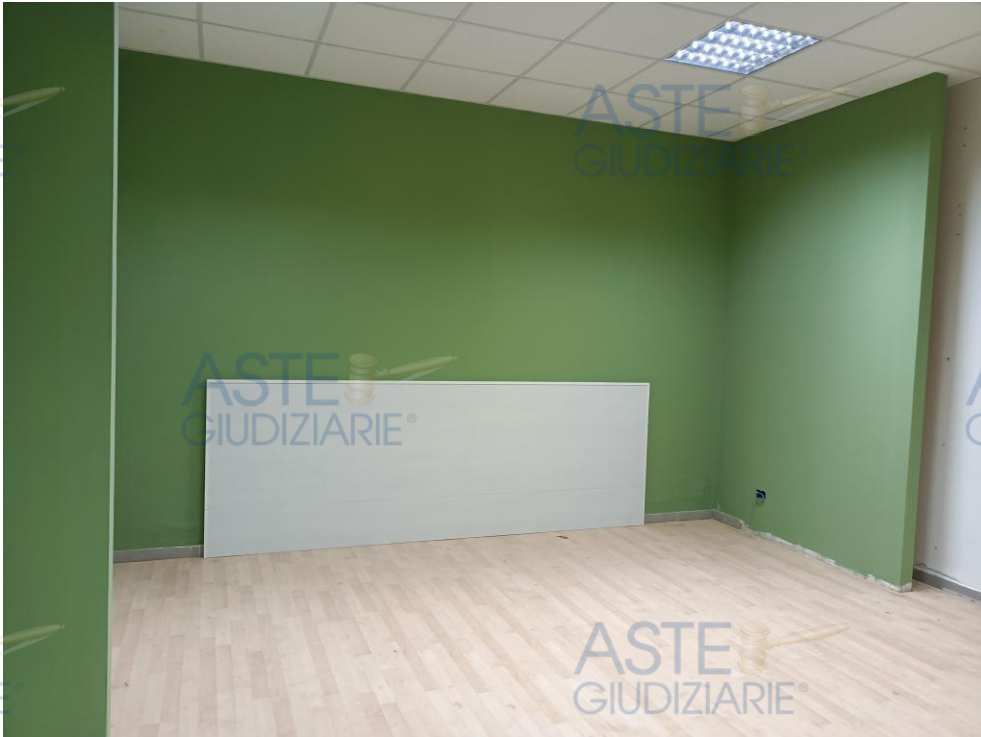
Foto n. 29 – Corpo A – Palazzina Uffici – Piano seminterrato.
