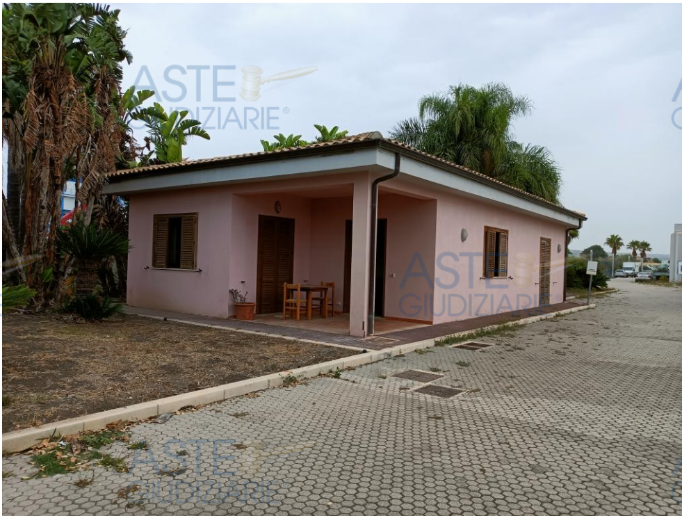
Foto n. 52 – Corpo F – Alloggio custode.
