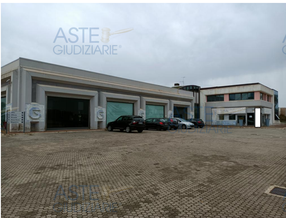
Foto n. 10 – Impianto produttivo per assemblaggio di macchine ed arredi per attività commerciali – Vista esterna.
