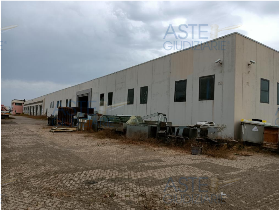
Foto n. 3 – Impianto produttivo per assemblaggio di macchine ed arredi per attività commerciali – Vista esterna.
