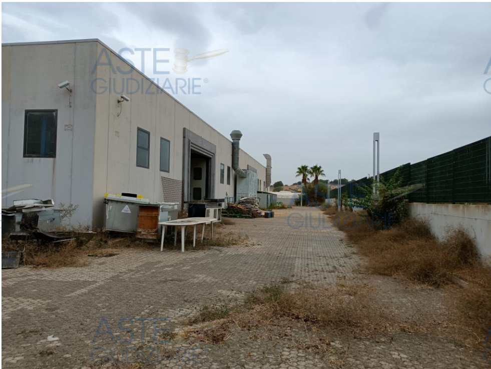
Foto n. 4 – Impianto produttivo per assemblaggio di macchine ed arredi per attività commerciali – Vista esterna.
