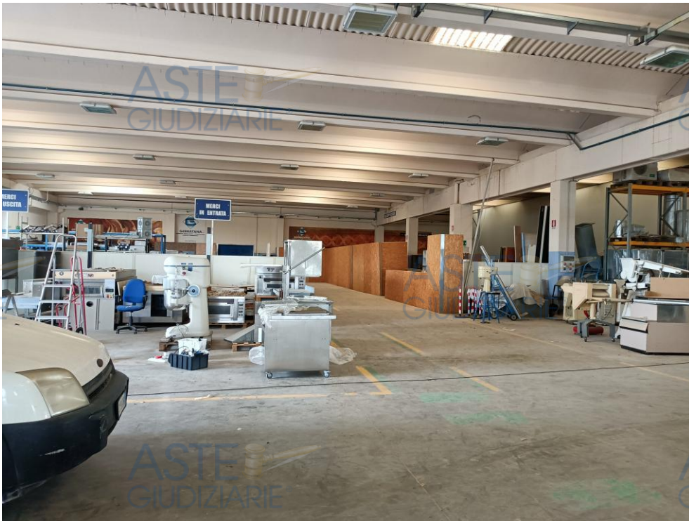
Foto n. 36 – Corpo C – Capannone – Sala produzione.
