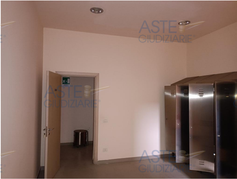
Foto n. 47 – Corpo E – Capannone – Mensa e servizi.
