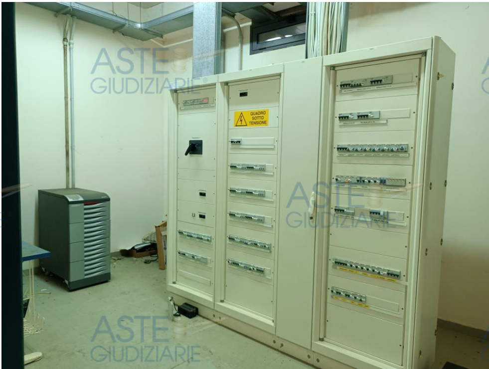
Foto n. 30 – Corpo A – Palazzina Uffici – Piano seminterrato.
