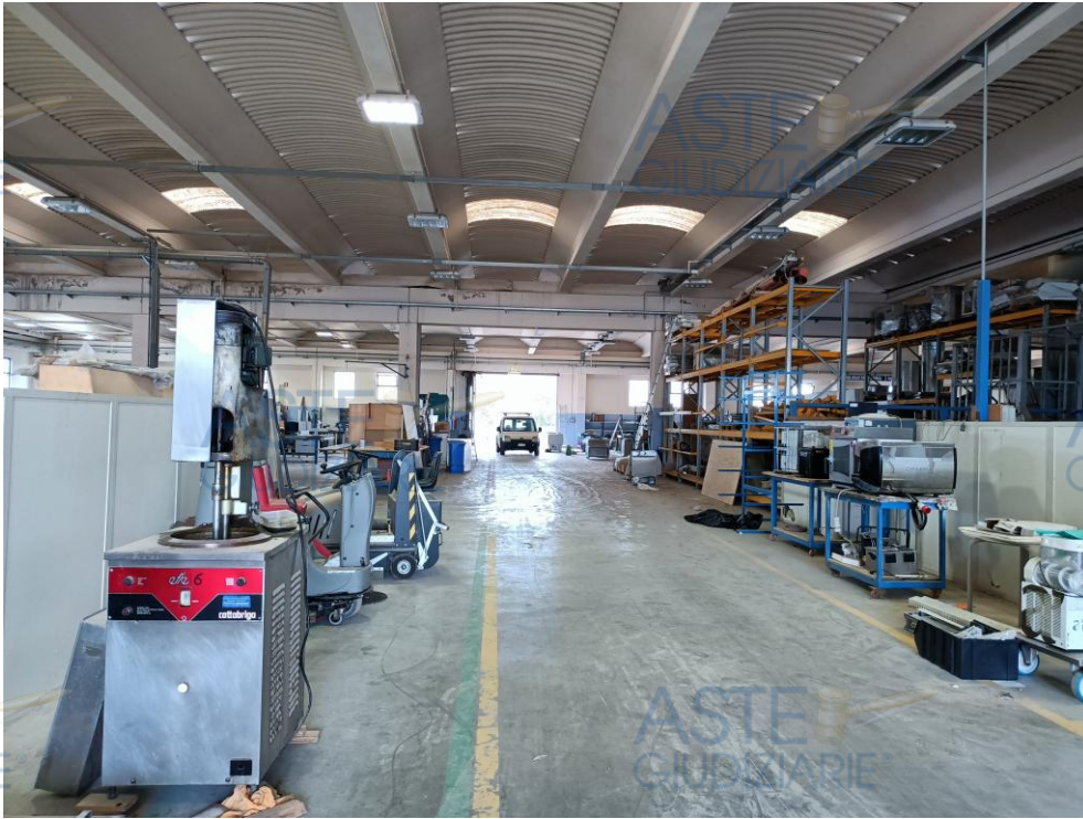
Foto n. 35 – Corpo C – Capannone – Sala produzione.
