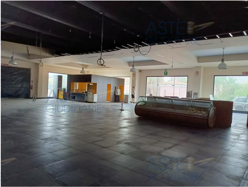
Foto n. 33 – Corpo B – Capannone – Sala esposizione.
