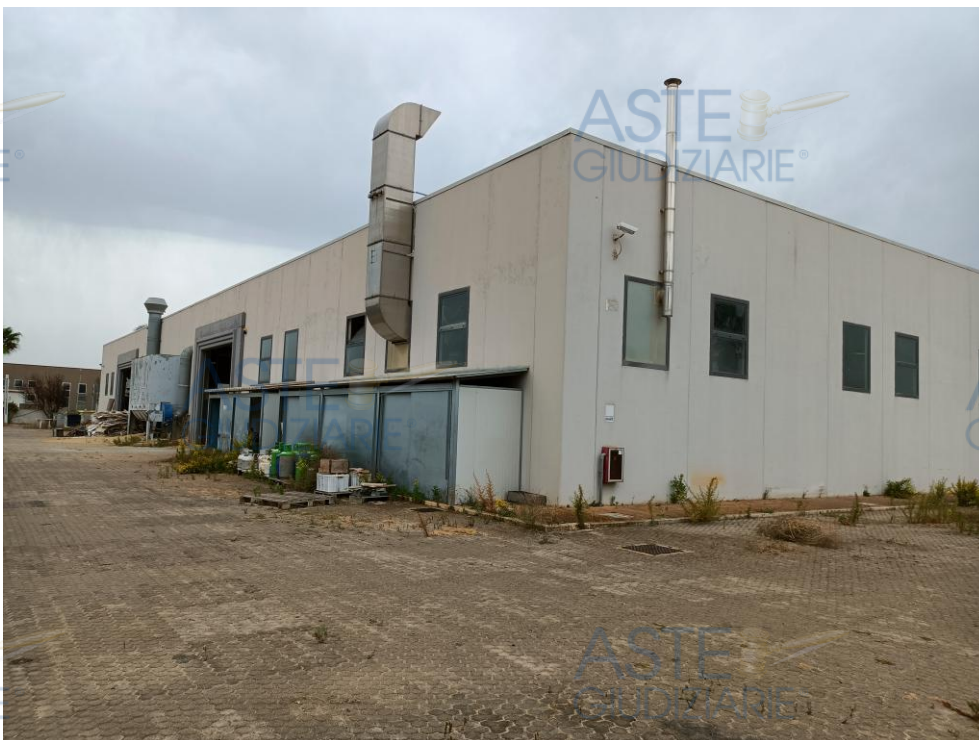
Foto n. 5 – Impianto produttivo per assemblaggio di macchine ed arredi per attività commerciali – Vista esterna.
