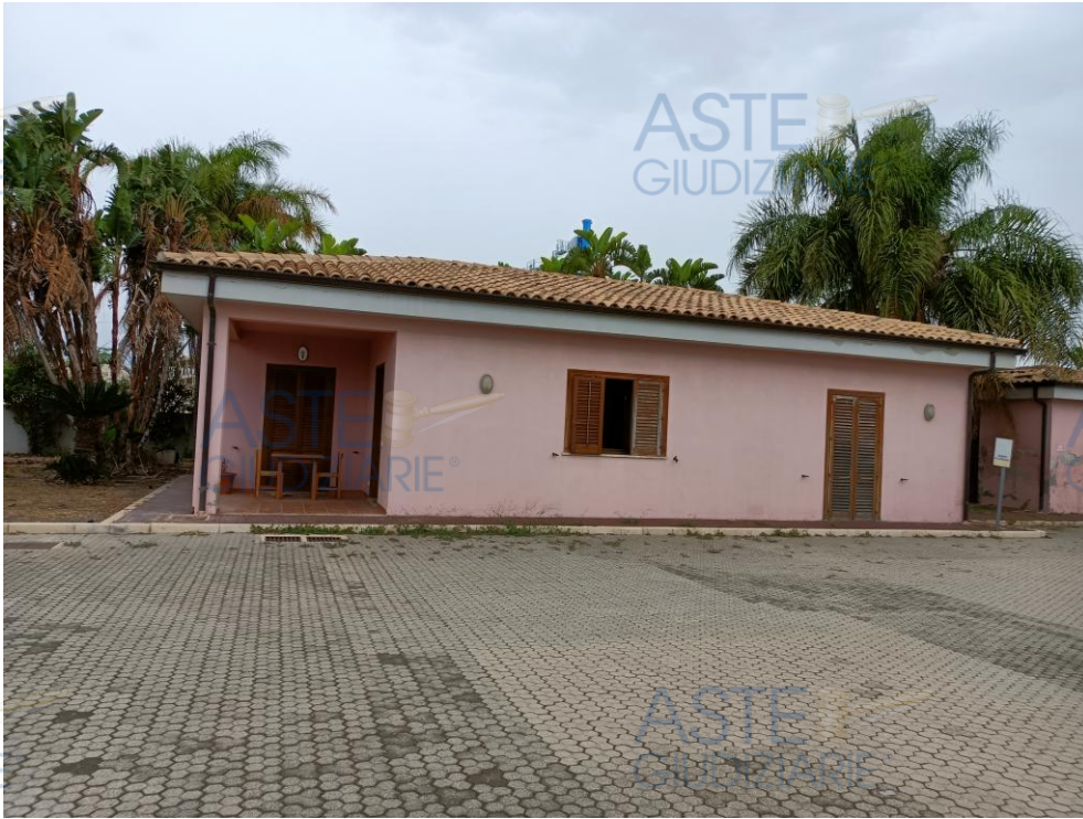
Foto n. 51 – Corpo F – Alloggio custode.
