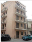
FOTO 3 – Ingresso al locale garage
