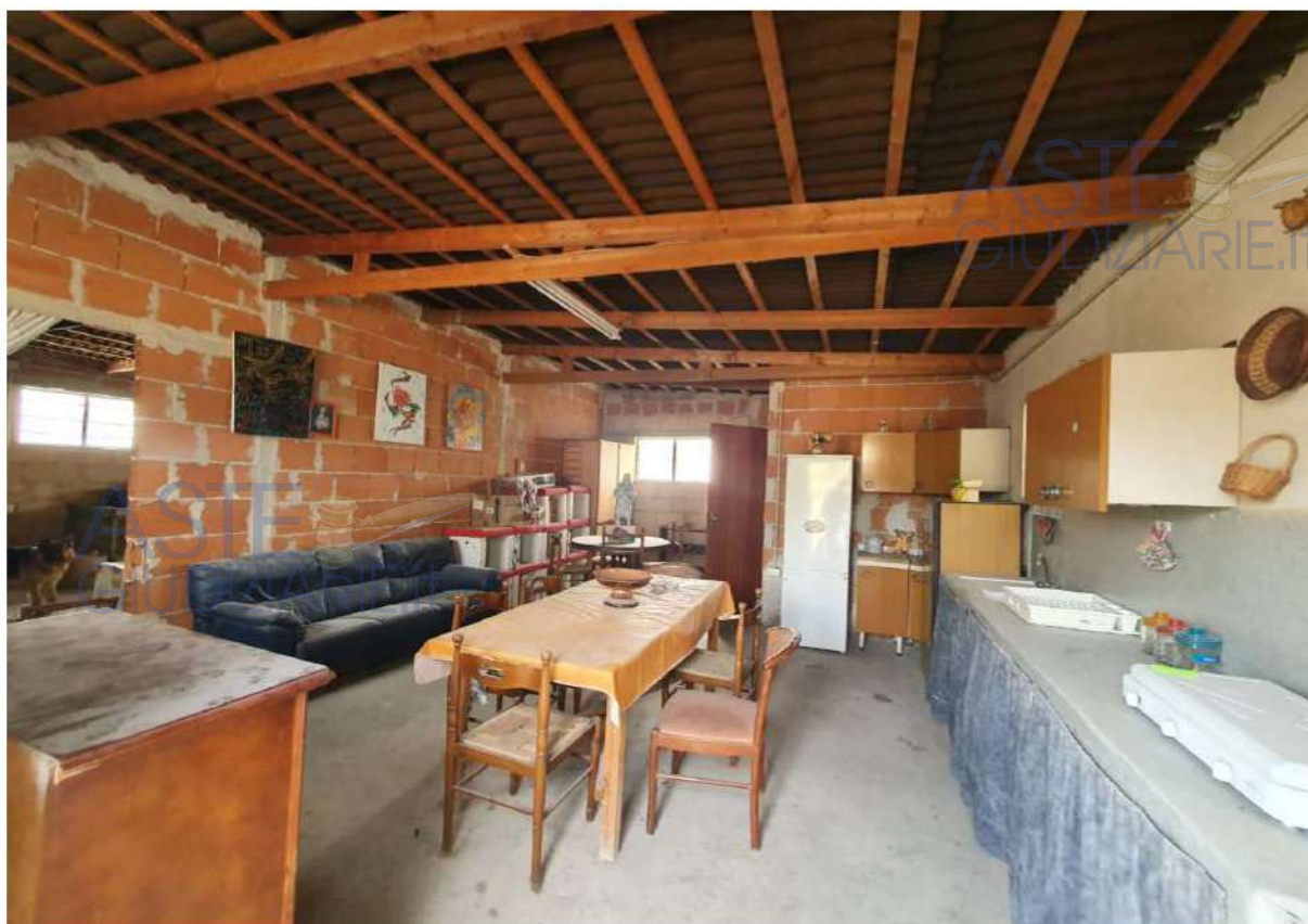
Foto 9 Lotto unico – Fabbricato abusivo e non censito particella 7 – vista interna
