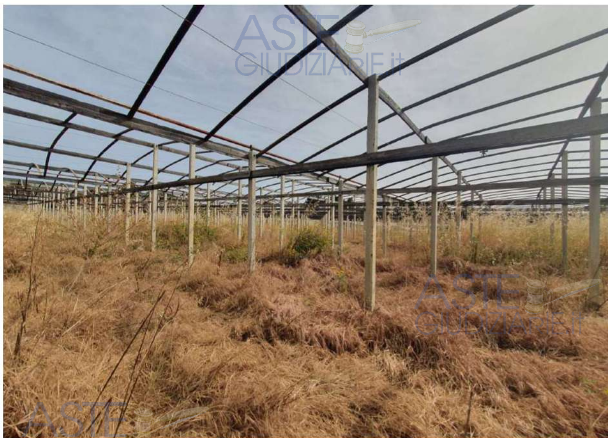
Foto 16 Lotto unico – Vista interna serra particella 7
