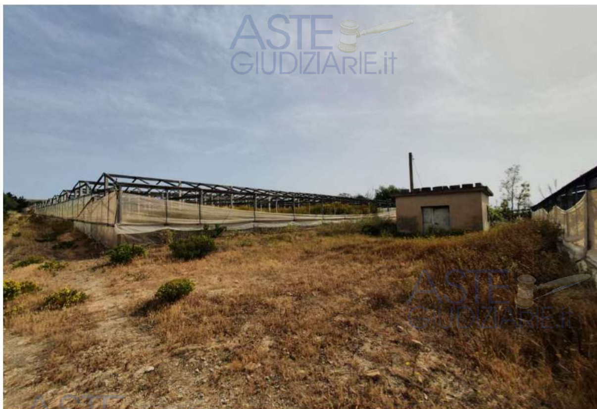
Foto 14 Lotto unico – Casotto con pozzo particella 245 non oggetto di pignoramento e serra 2 particella 7
