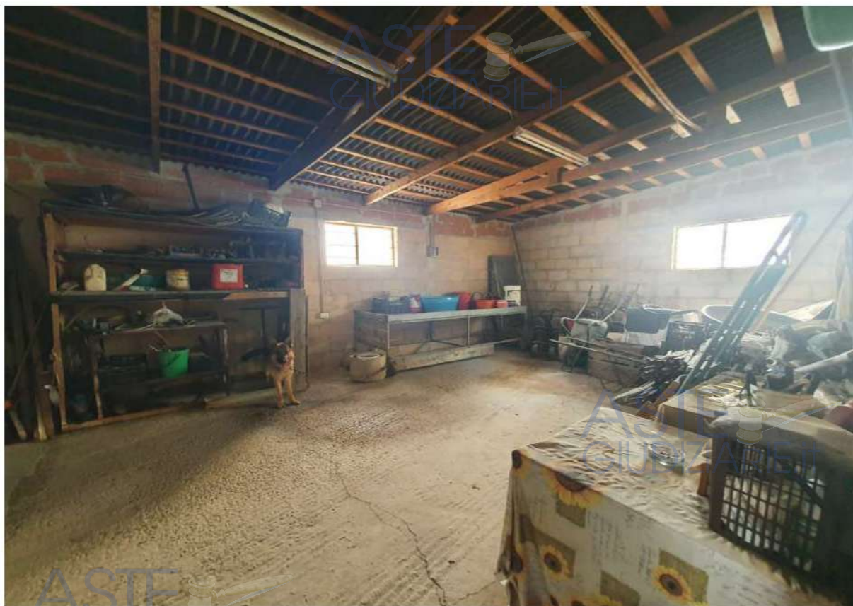
Foto 12 Lotto unico – Fabbricato abusivo e non censito particella 7 – vista interna
