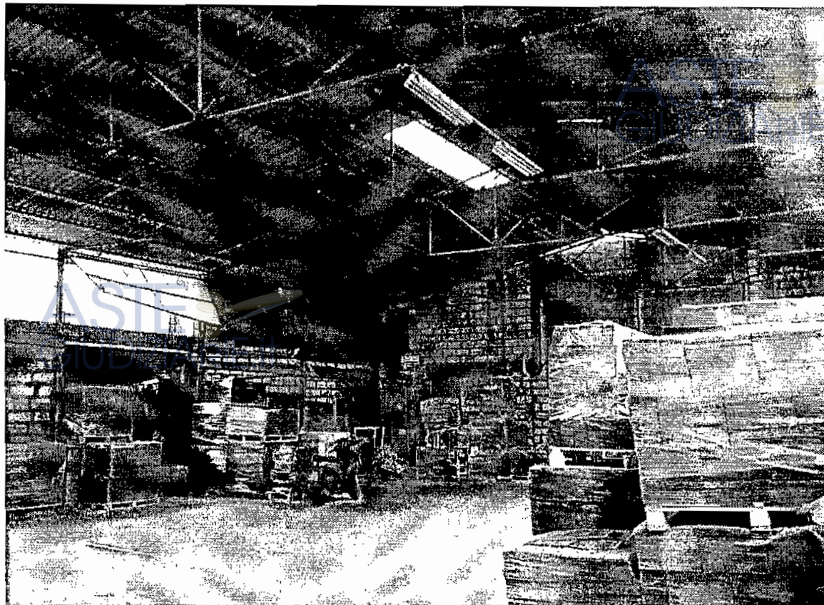
Foto 13. Interno locale Capannone/Deposito
