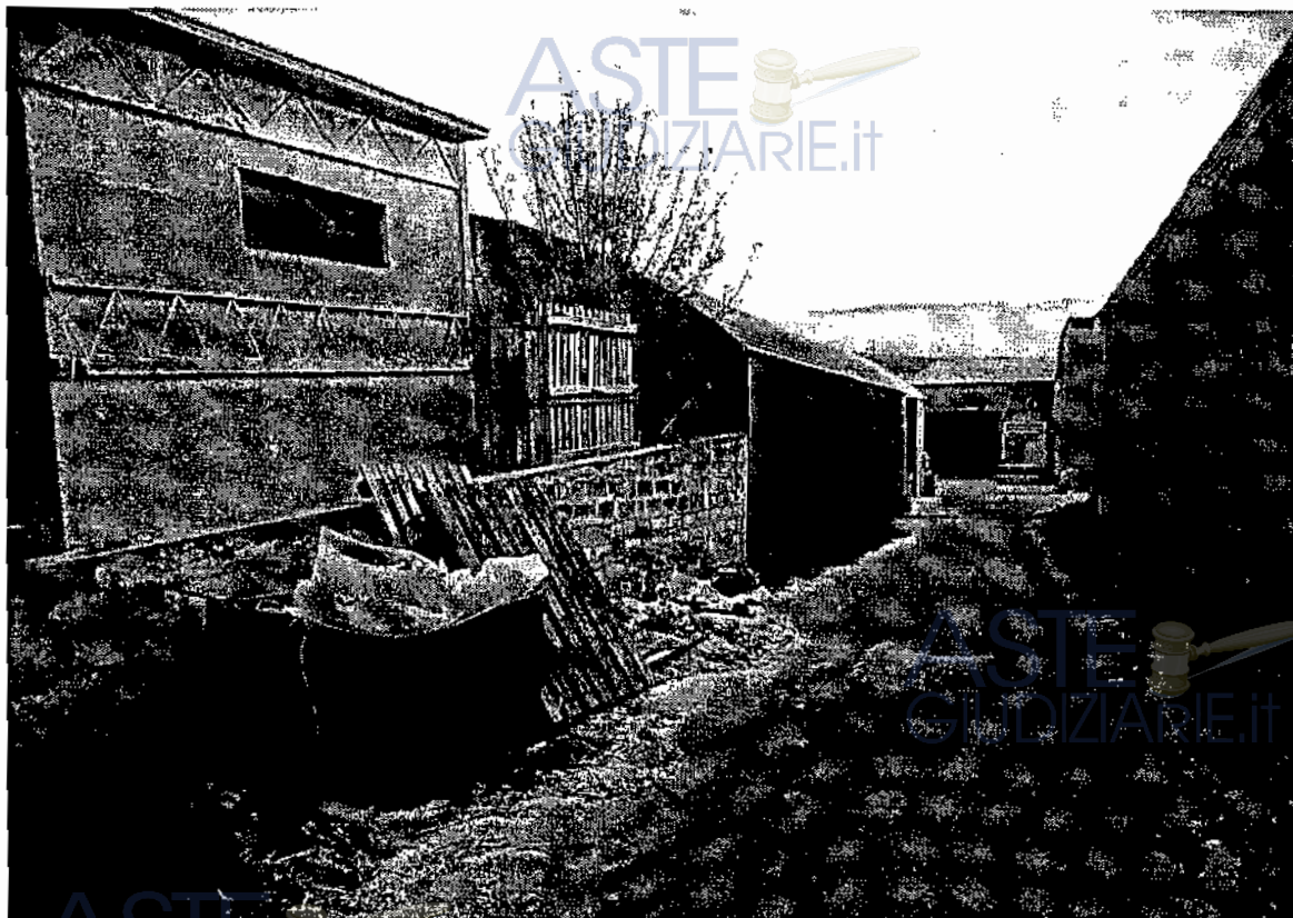
Foto 06. Dalla stalla verso il Capannone/Deposito
