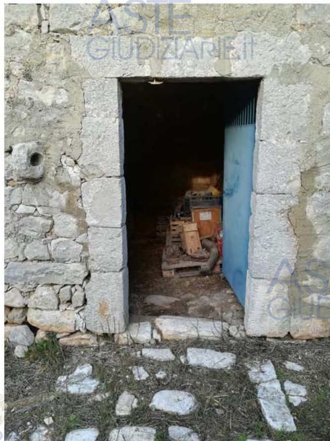
Foto 12 – particolare ingresso b) p.la 272 sub 1 fg 36 di Comiso – c.da Crocilla
