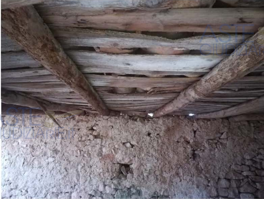
Foto 33 – tetto - p.lla 273 sub 1 fg 36 di Comiso – c.da Crocilla
