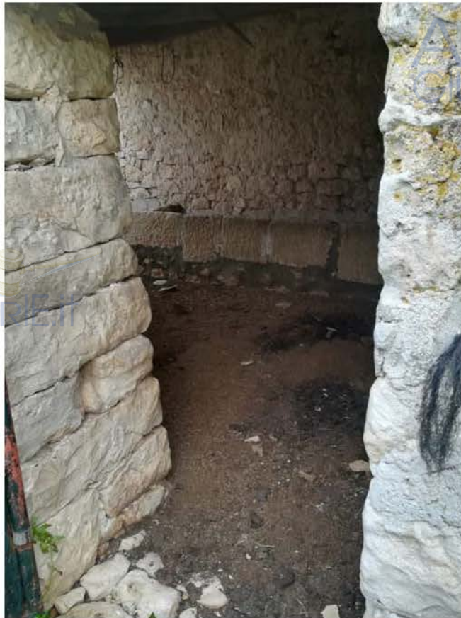
Foto 29 – ingresso stalla - p.lla 273 sub 1 fg 36 di Comiso – c.da Crocilla
