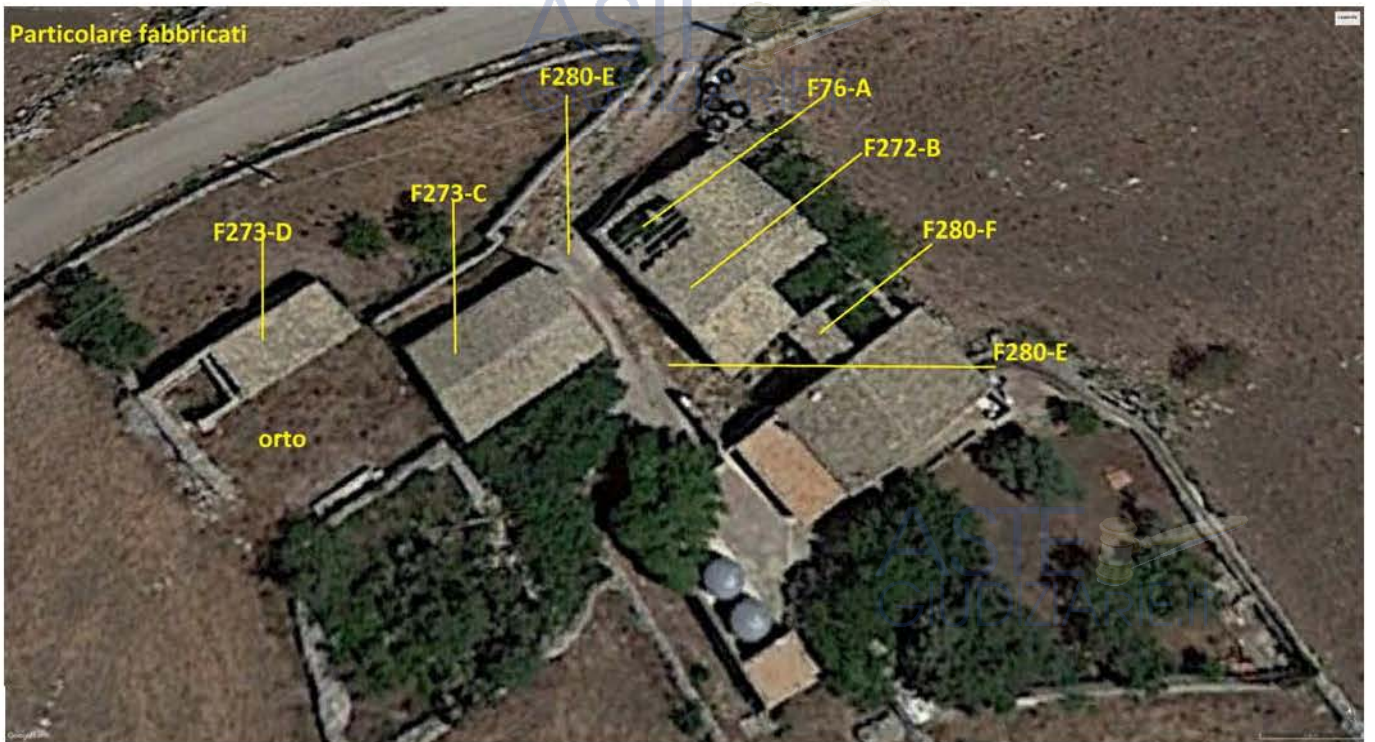
Foto aerea – c.da Crocilla, Comiso - particolare fabbricati
