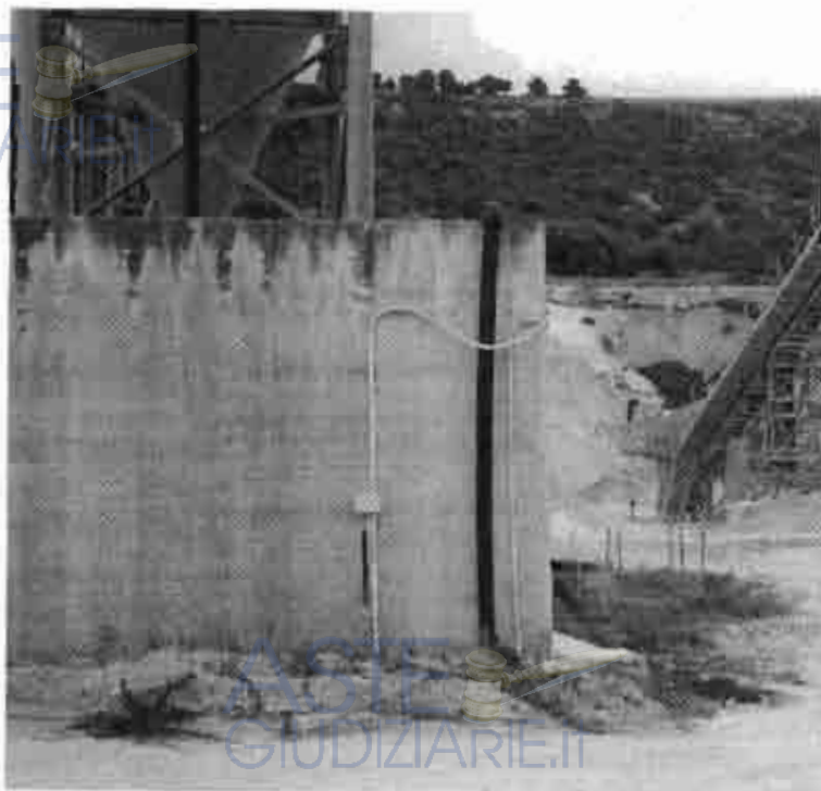
Struttura in c.a. per impianto di depurazione
