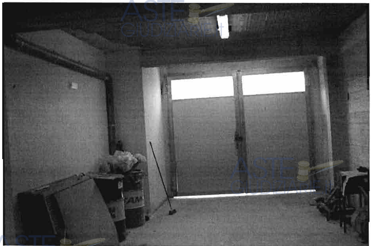
Vista interna portone doppio per accesso a locale deposito/spogliatoio
