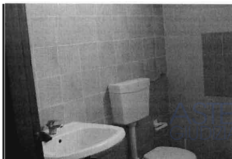
Locale spogliatoio particolare finiture bagni
