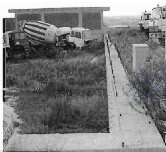
Muri di sostegno e di recinzione
