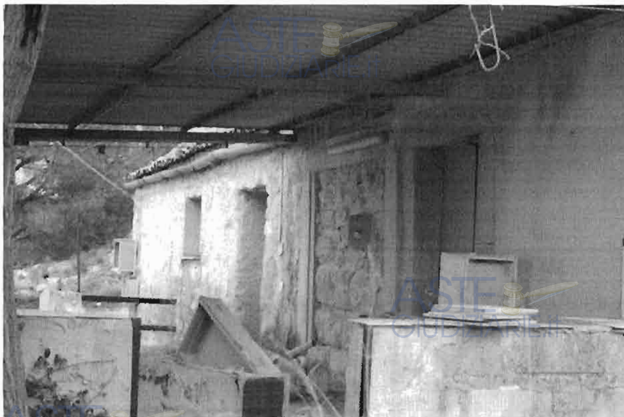
Fabbricato rurale vista lato ovest con dettaglio ingressi abitazione
