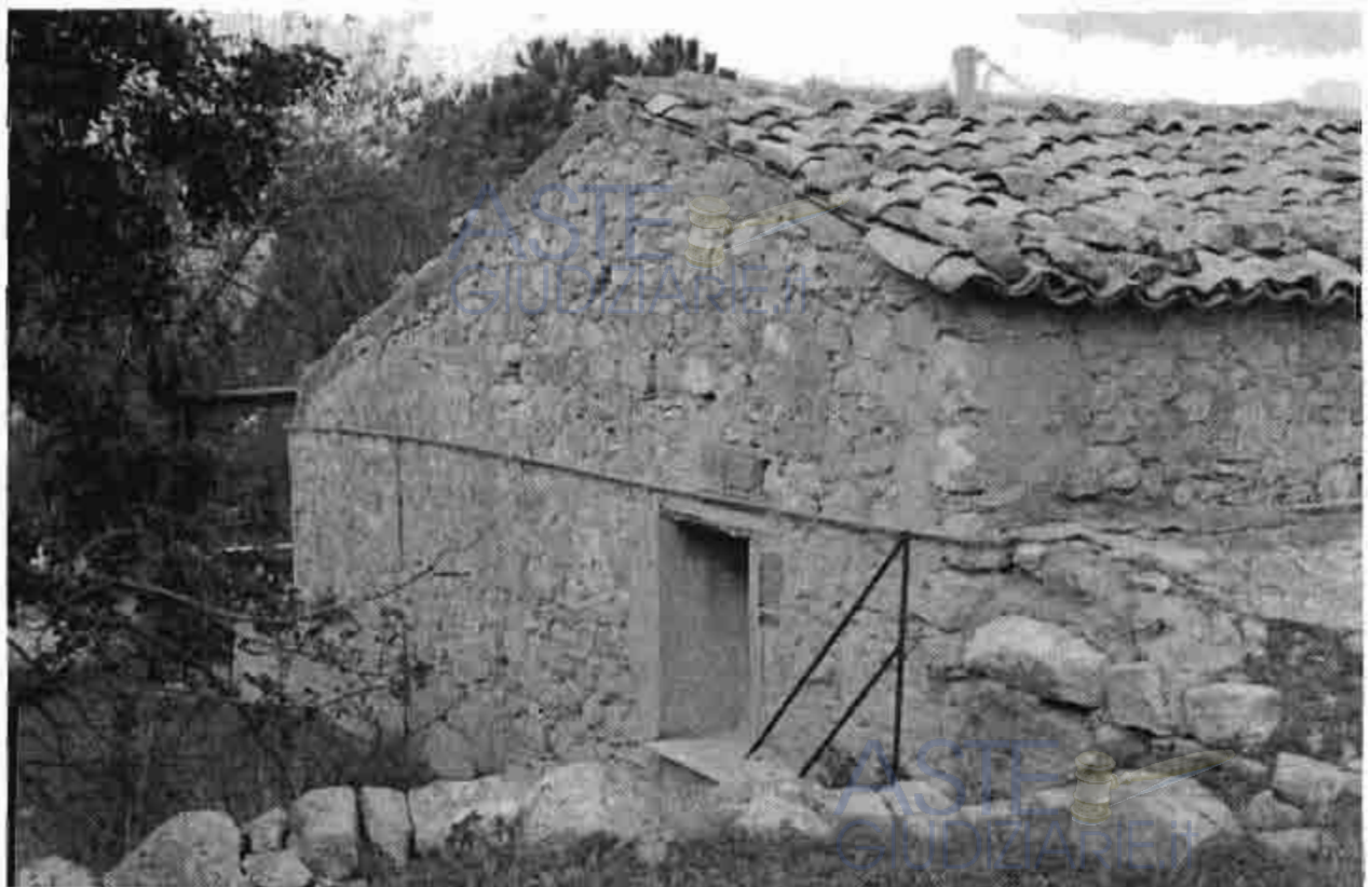
Fabbricato rurale vista lato sud
