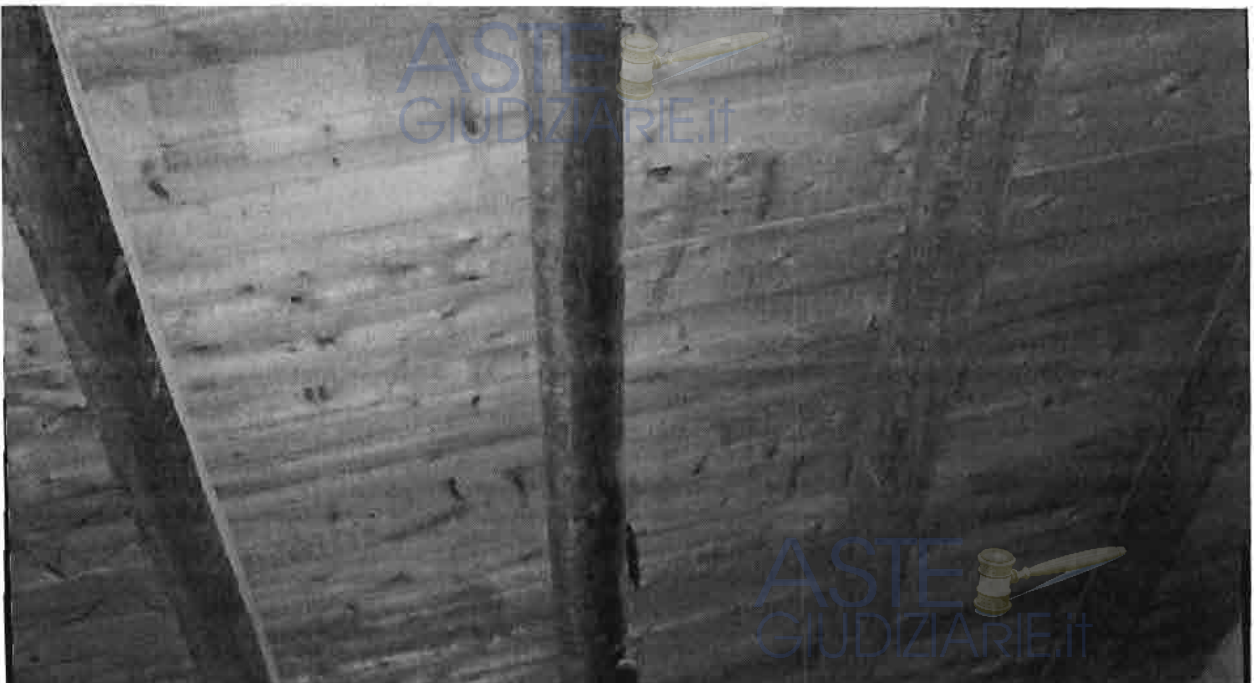
Fabbricato rurale vista interna dettaglio copertura
