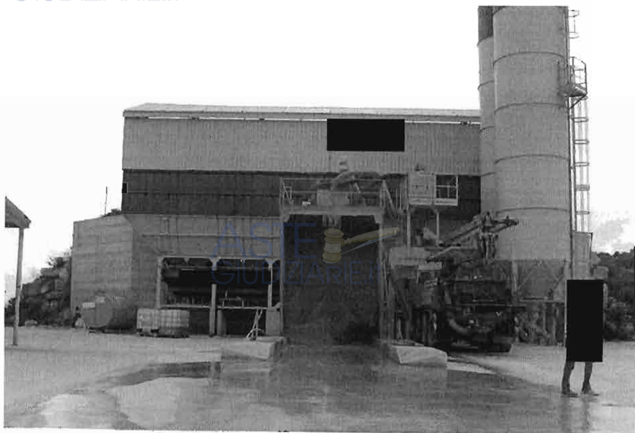
Struttura in c.a. per impianto betonaggio
