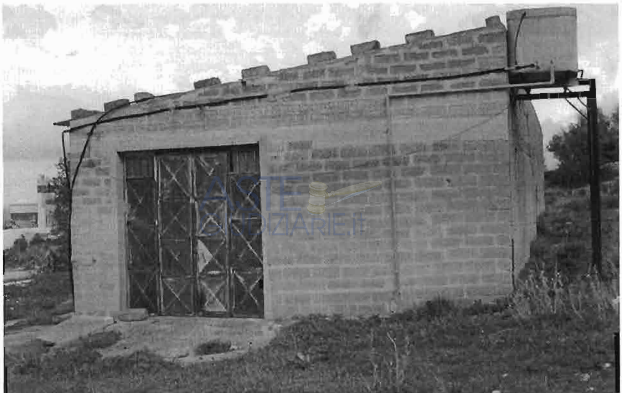
Fabbricato rurale vista lato sud
