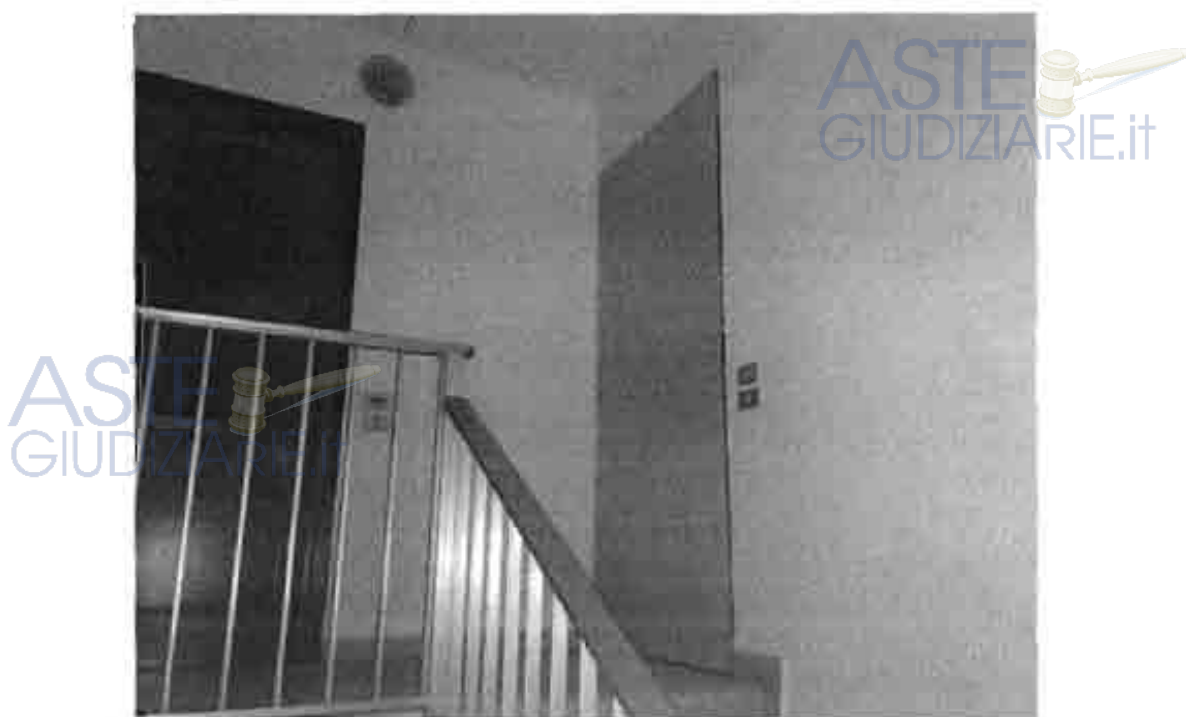
Vista finiture scala di accesso all'appartamento e porta di ingresso dello stesso
