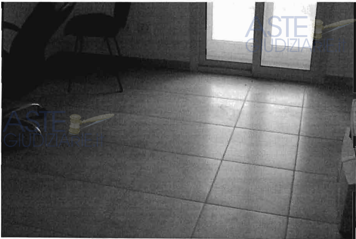
Corpo uffici particolare finiture piastrelle locali interni
