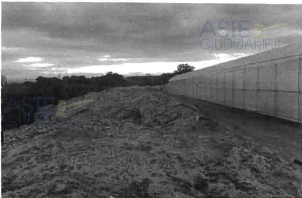
Vista area spianata e realizzazione serra da parte di terzi
