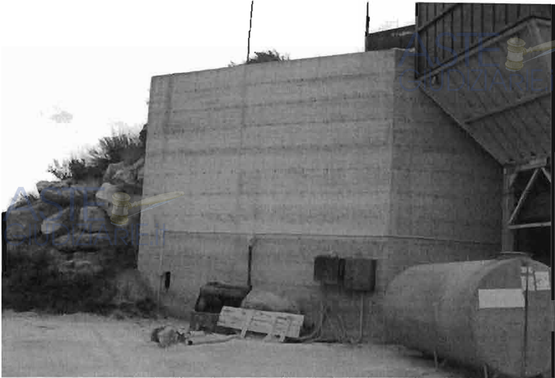
Struttura in c.a. per impianto betonaggio
