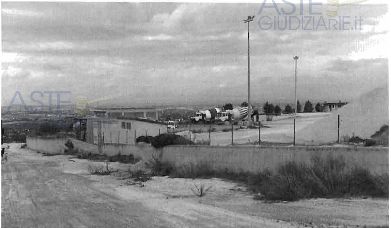
Area particella 1378 con dettaglio dei pali di illuminazione
