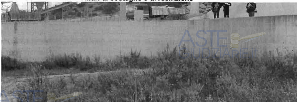
Muri di sostegno e di recinzione
