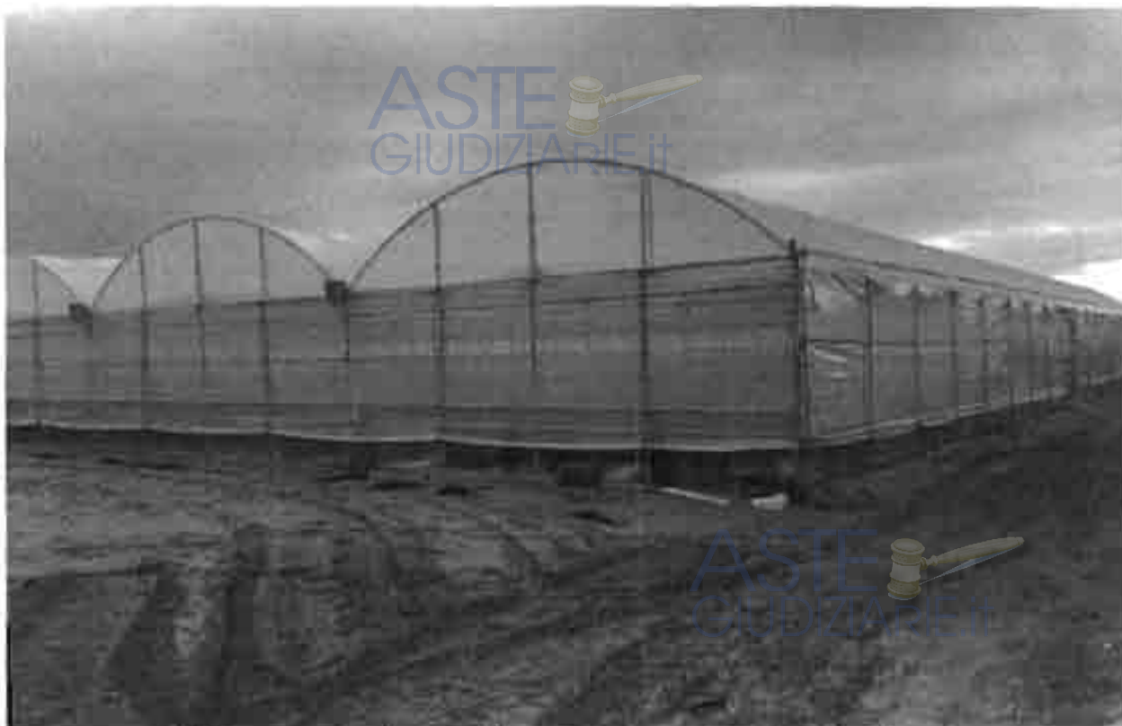
Vista area spianata e realizzazione serra da parte di terzi
