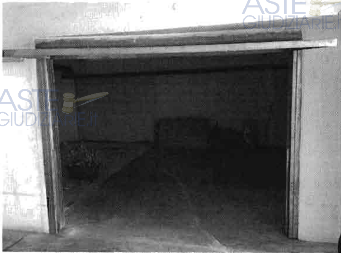
Vista dell'ingresso al garage tramite saracinesca in acciaio
