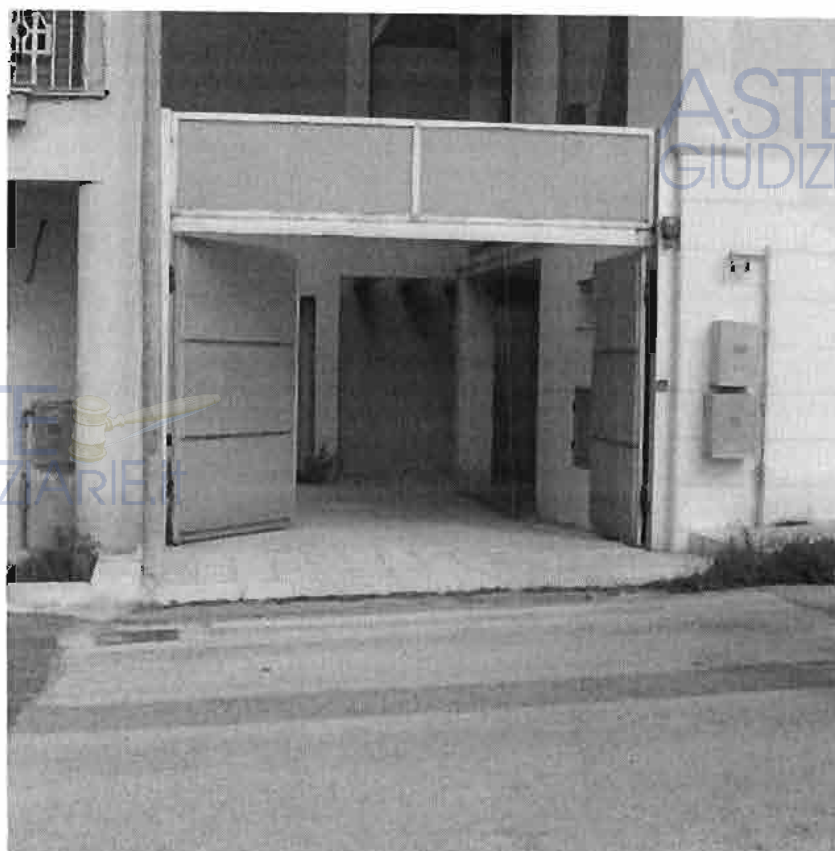
Vista dall'esterno dell'ingresso tramite rampa ai locali a livello -1 sotto strada tramite cancello in acciaio zincato
