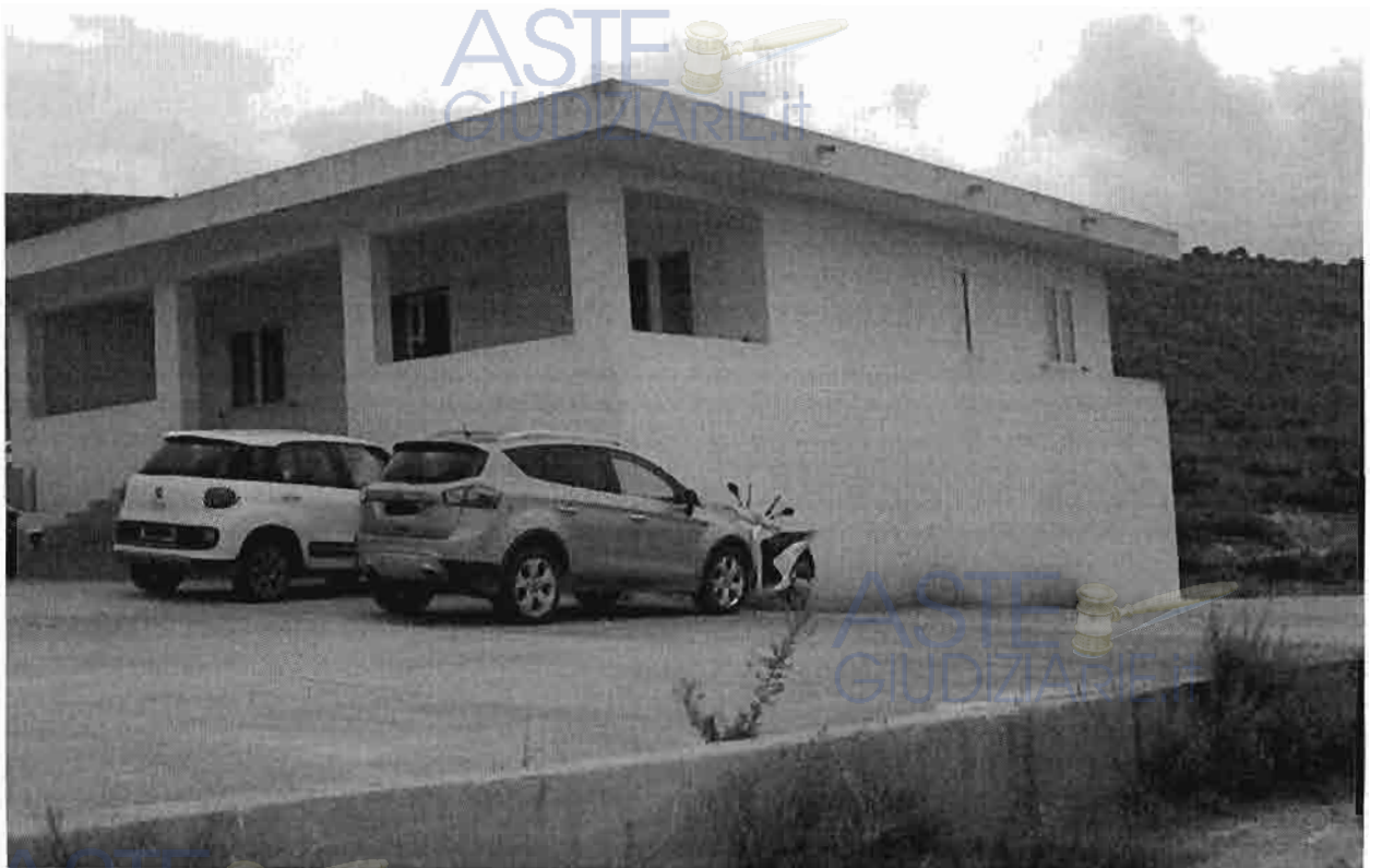
Corpo uffici lato Nord/Ovest
