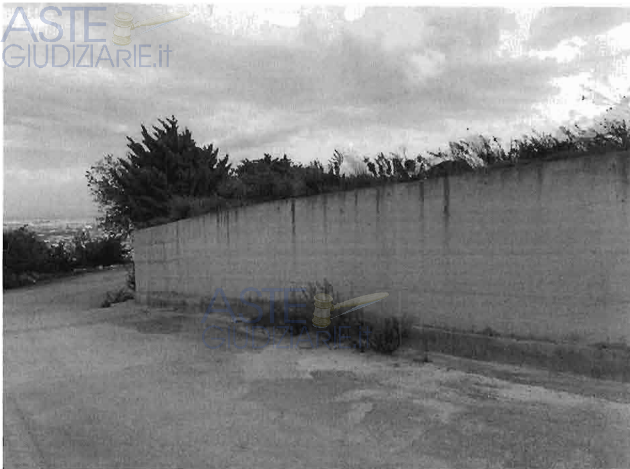
Muri di sostegno e di recinzione
