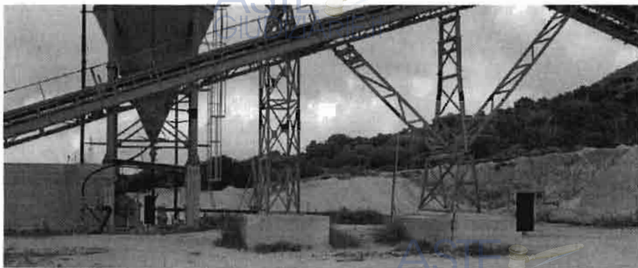
Struttura in c.a. per impianto di frantumazione piattaforme frantoio
