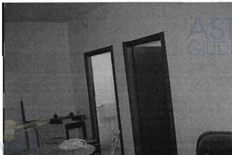
Locale spogliatoio particolare finiture porte
