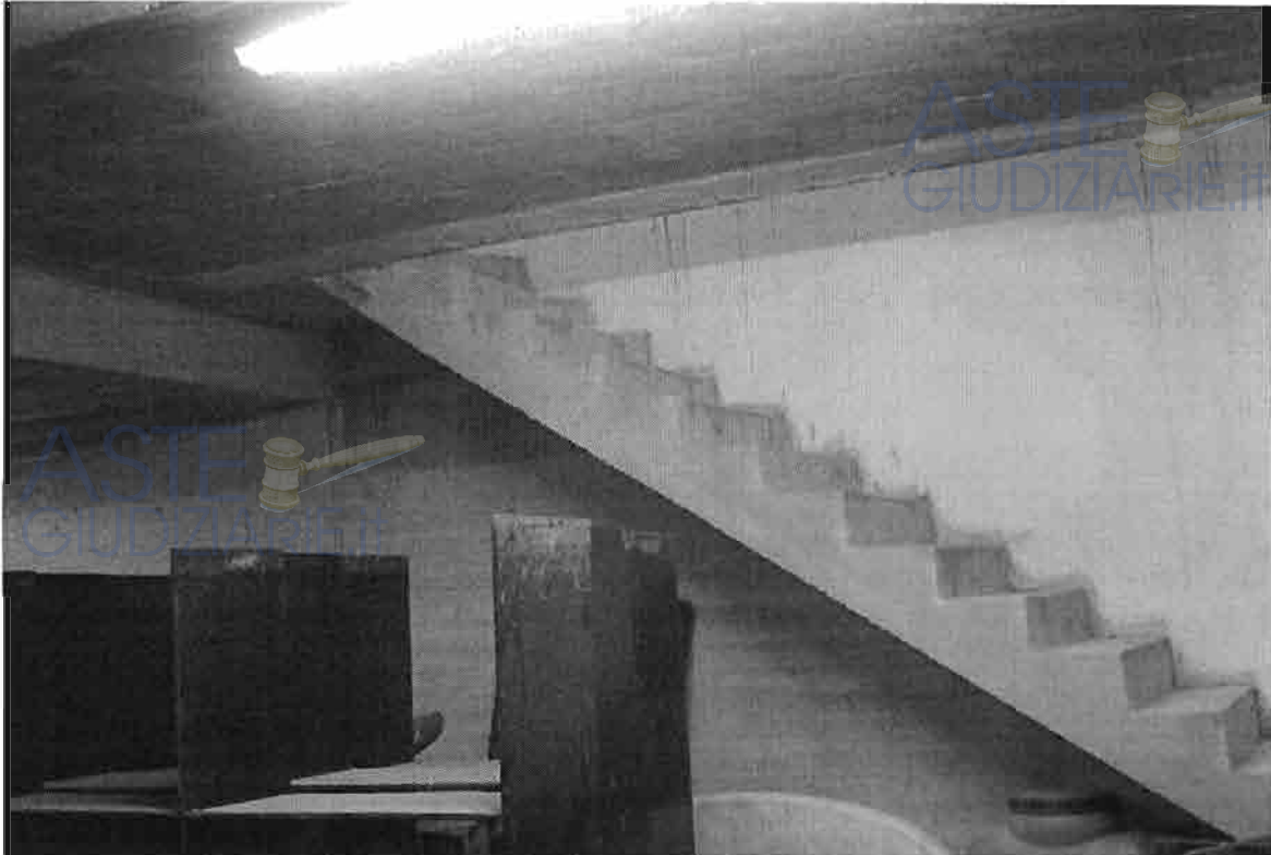
Locale deposito particolare scale accesso a corpo uffici
