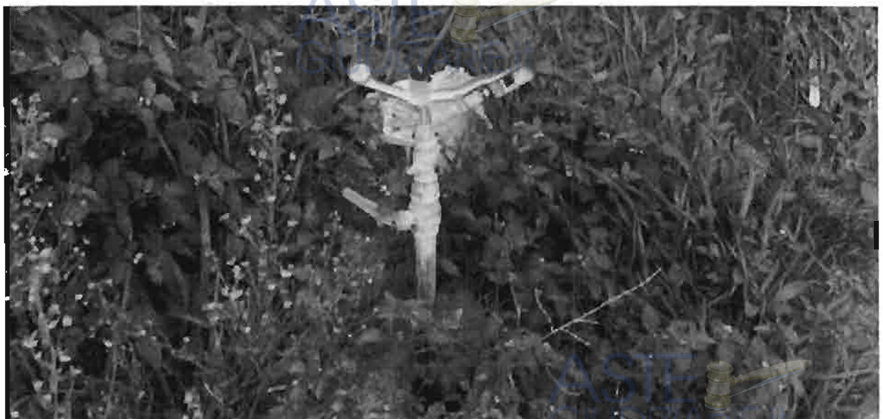
Area particella 1378 particolare del sistema di irrigazione a pioggia
