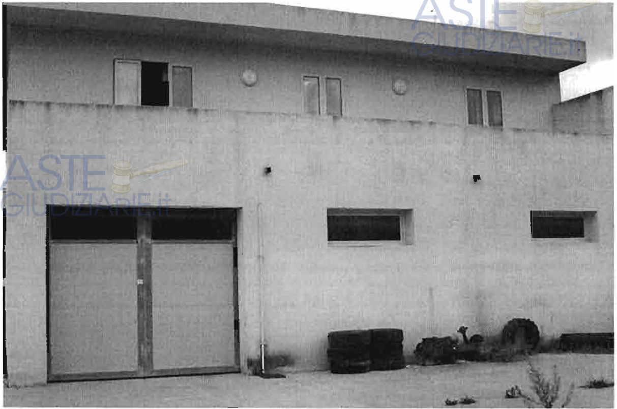
Vista esterna locale deposito/spogliatoio lato Sud/Ovest
