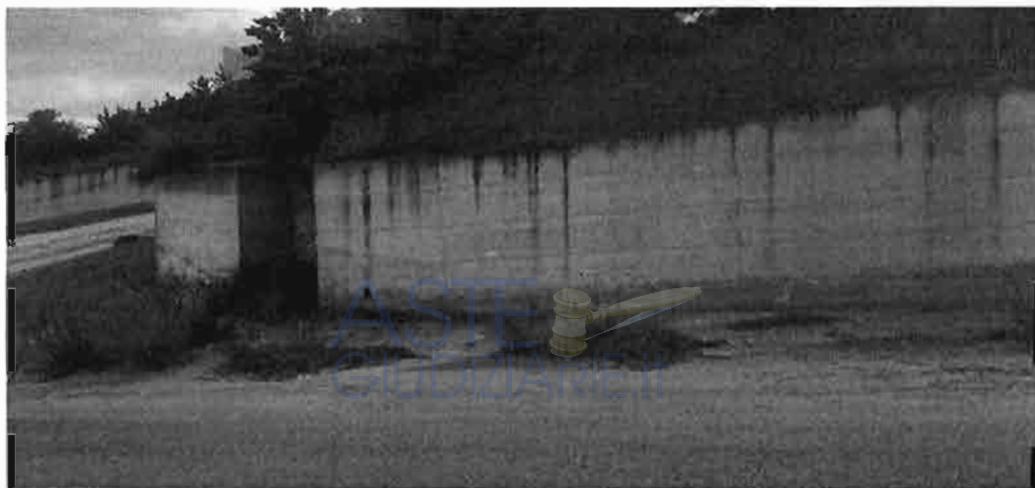
Muri di sostegno e di recinzione
