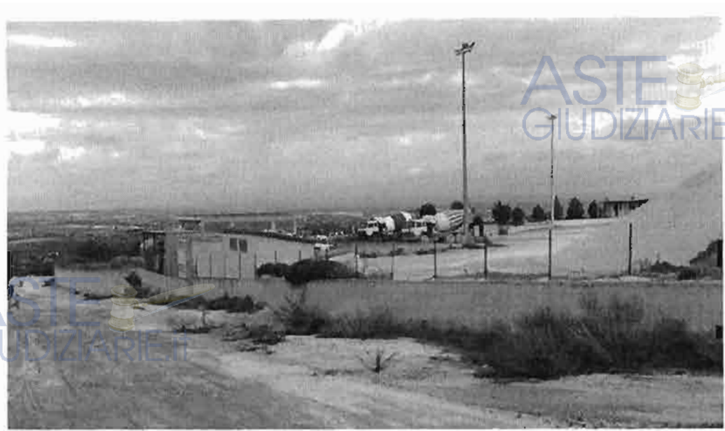
Muri di sostegno e di recinzione
