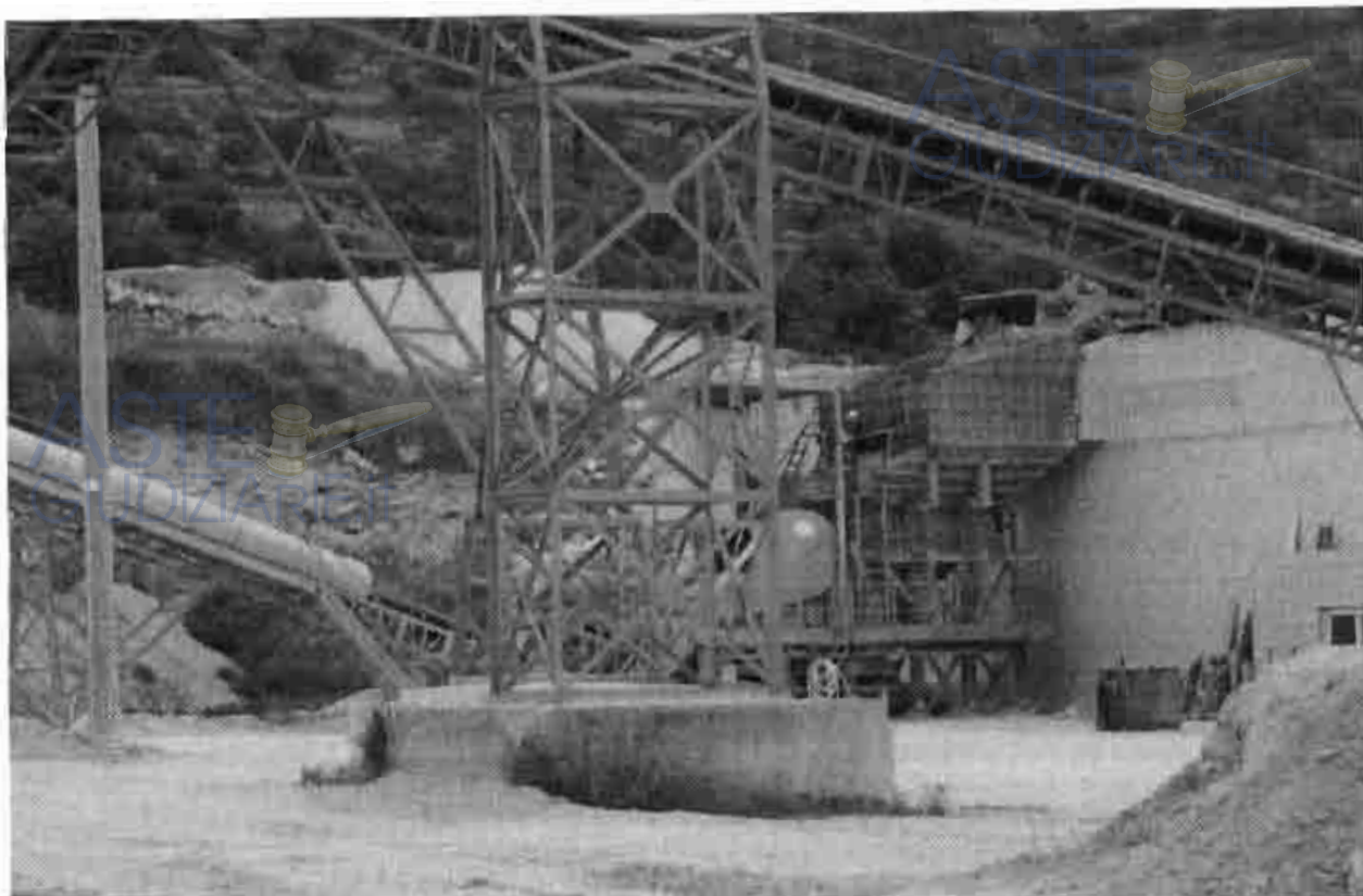
Struttura in c.a. per impianto di frantumazione piattaforme frantoio
