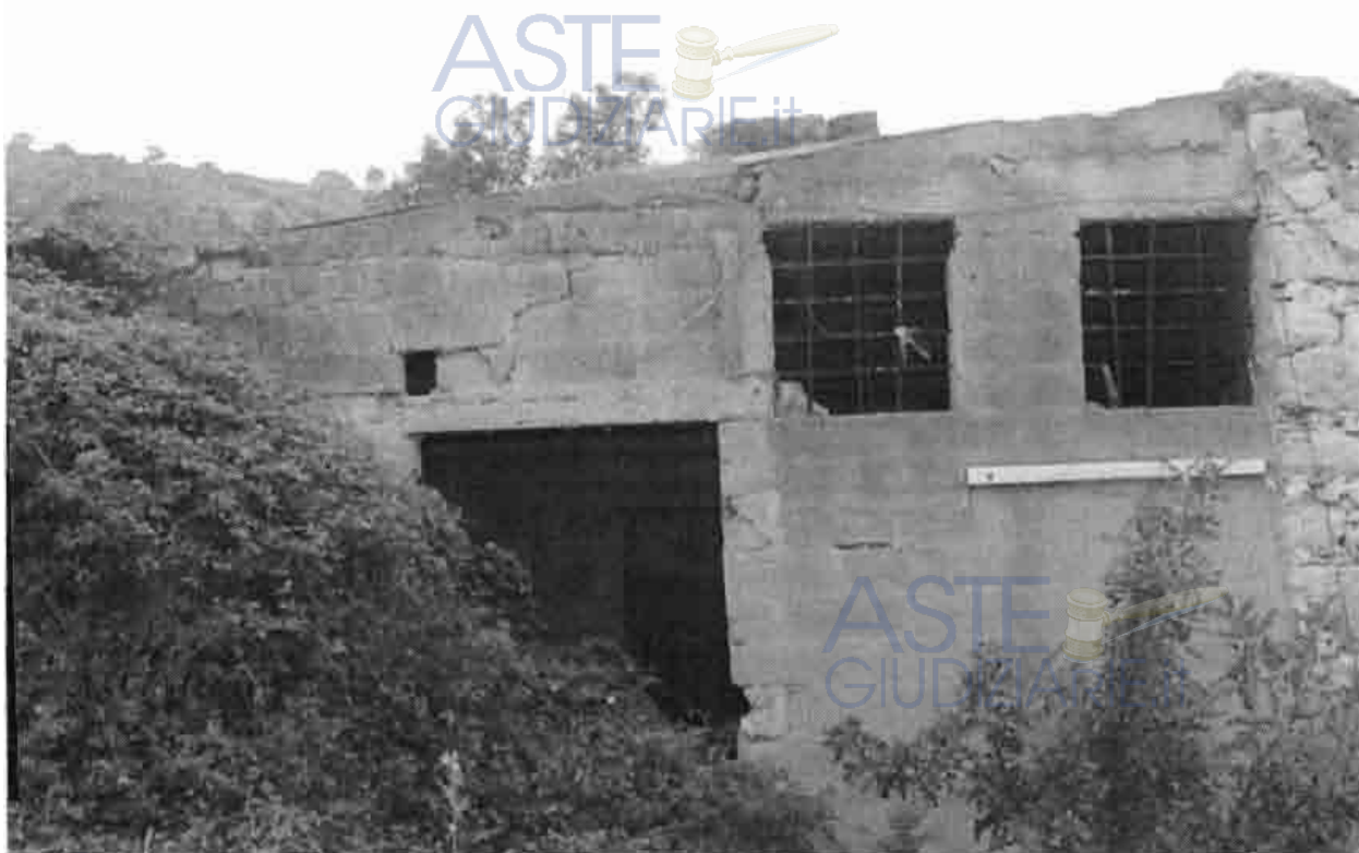
Fabbricato rurale vista lato nord con dettaglio ingresso stalla
