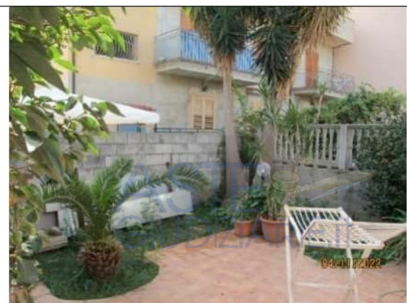
Foto 8. Vista esterna della corte, lato Sud, a servizio del fabbricato, con accesso diretto dalla corte, lato Est
