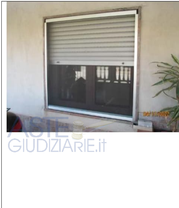
Foto 26. Particolare della tipologia di finestra in alluminio, con doppio vetro, a due ante, con avvolgibile in PVC e cassonetto integrato
