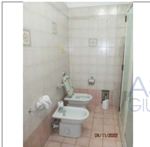
Foto 22. Vista del bagno WC, lato Sud-Ovest
