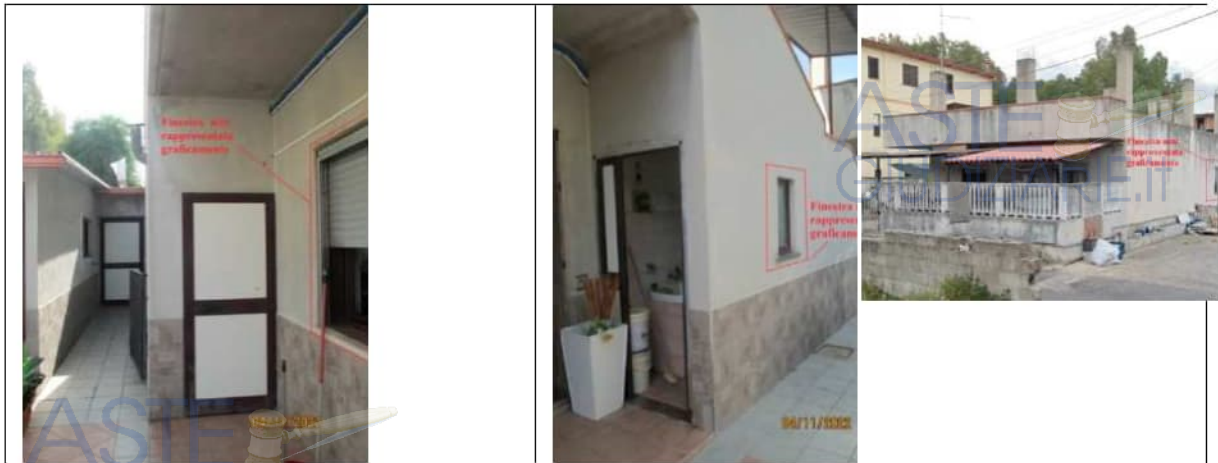
Diffformità come evidenziata al punto 1
