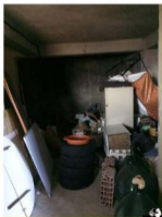
deposito piano seminterrato
