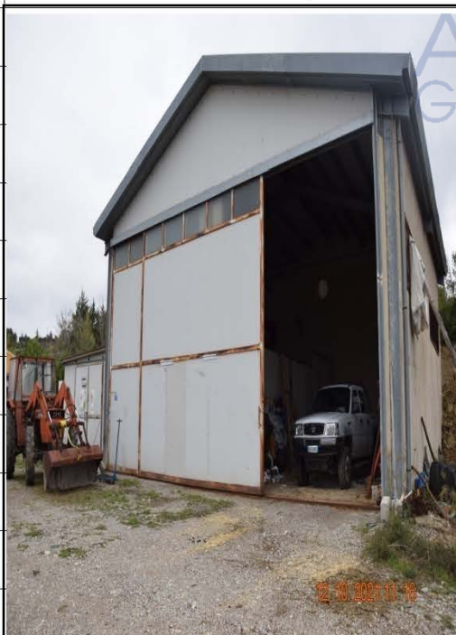
Foto Prospetto Principale " P.T. Sub 2"
