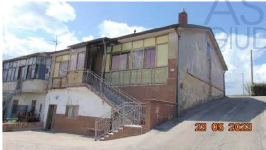
Foto n. 1 – Scala di accesso
