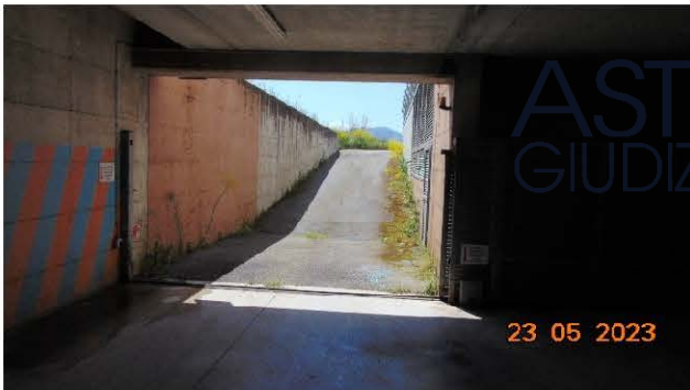
Foto n. 6 – Tunnel accesso garage
