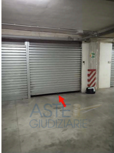
Corsia di manovra e serranda di accesso
