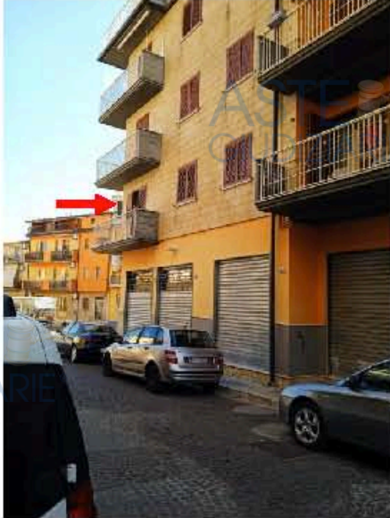
Facciata stabile lato ovest
