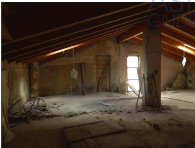
Foto locale deposito – piano sottotetto
