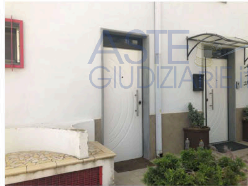
Accesso gradinata in calcestruzzo
