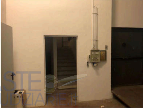
Gradinata interna e montacarichi
