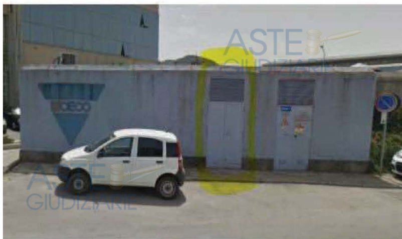
Ingresso deposito indipendente (giallo).
