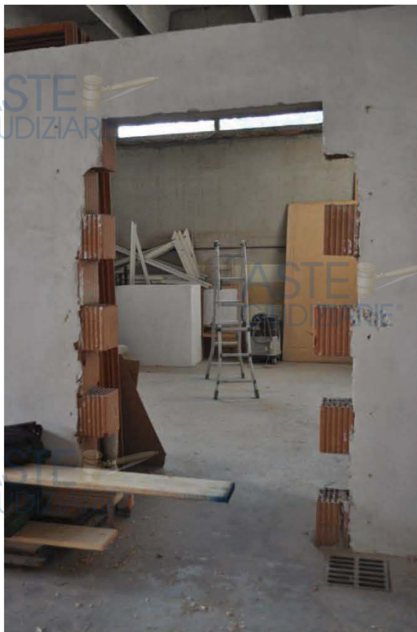
Deposito (particella 1846, sub 52).
