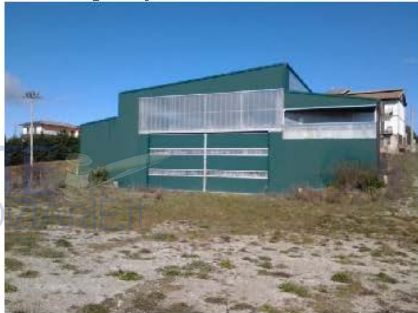
Foto ingresso piano seminterrato
