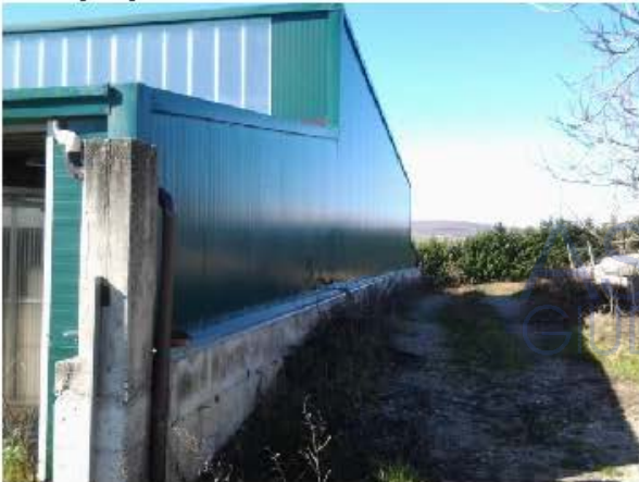
Foto prospetto lato a monte
