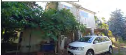
Vista corpo di fabbrica principale, lato Nord-Est
