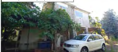
Vista corpo di fabbrica principale, lato Nord-Est
