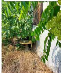
Ingresso abitazione (da rampa scale)
