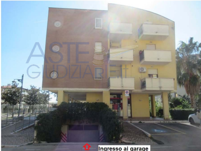
Foto 1 – Esterno fabbricato – ingresso ai garage
