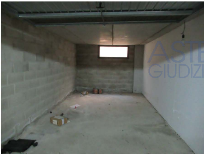
Foto 3 – Interno garage Sub. 19
