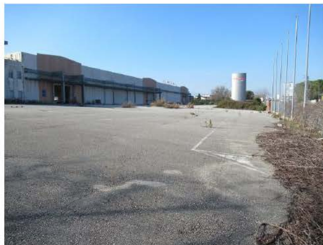
Foto 2 – Esterno opificio – corte Sub. 1
