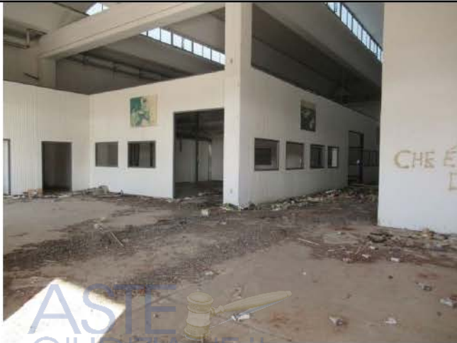
Foto 23 – Interno opificio – Sub. 2
