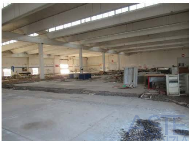
Foto 13 – Interno opificio Sub. 2
