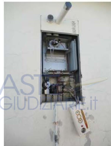
Foto 40 – Caldaia divelta
