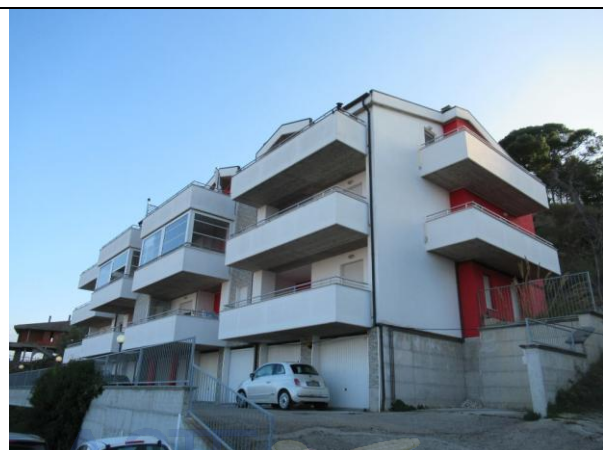
Foto n° 3 – Esterno del fabbricato condominiale.
