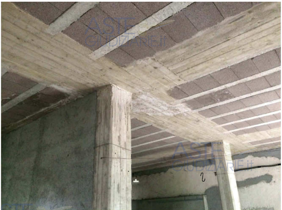
interno del magazzino - particolari sulla struttura in c.a. in elevazione
