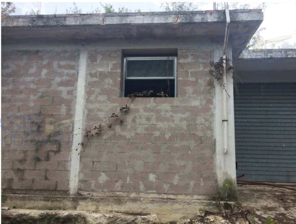
parte aggettante del magazzino - struttura portante in evidenza
