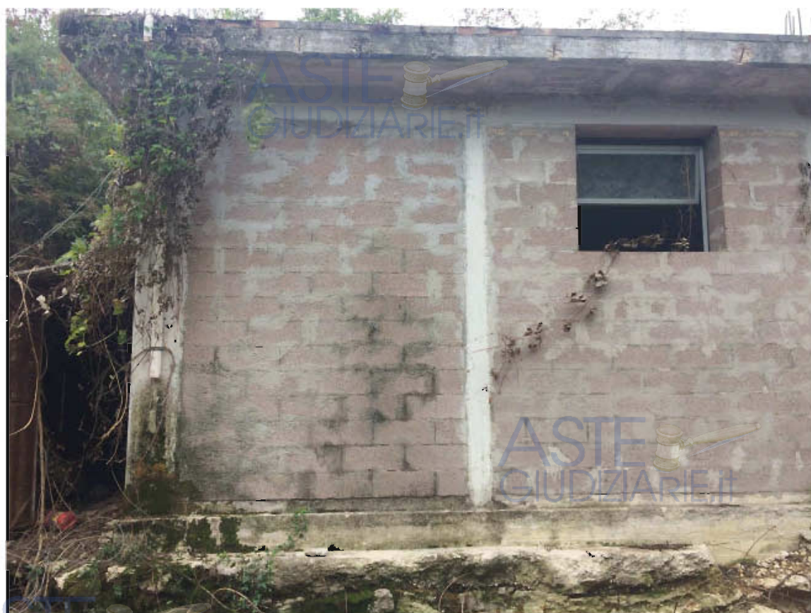
parte aggettante del magazzino - struttura portante in evidenza
