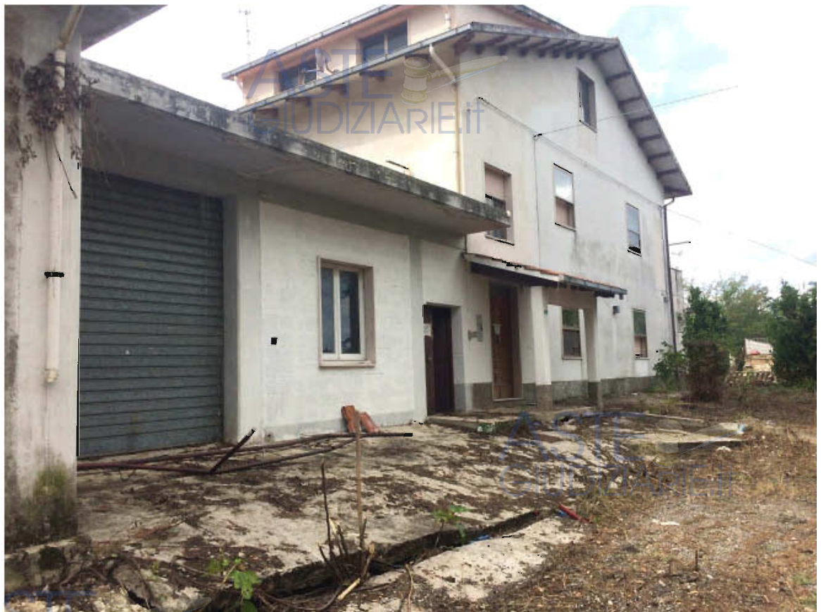
linea di frattura del terreno antistante in corpo in aggetto del magazzino
