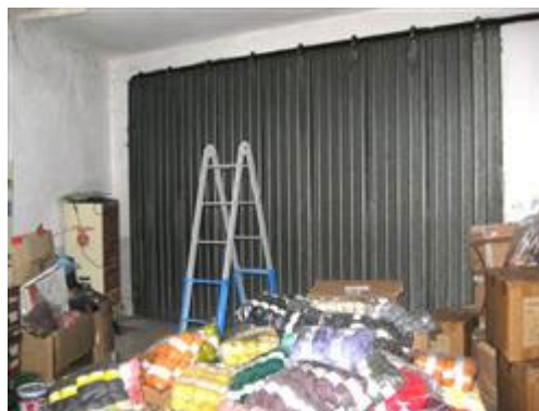
vista interna autorimessa
