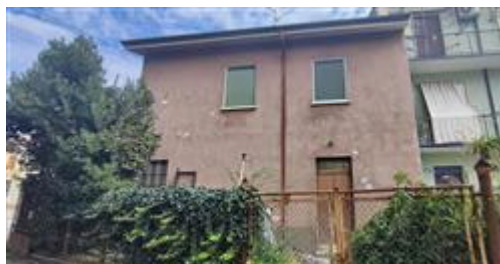
vista esterna lato ovest
