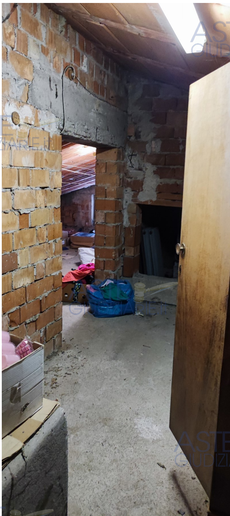
V12 Vista interna sottotetto
